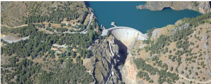
Presa de Quéntar
