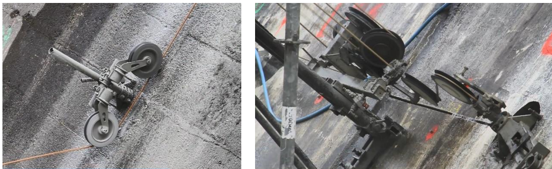
Figura 7.33. Corte del hormigón con hilo de diamante en paramento de presa (cortesía de Naturgy)
