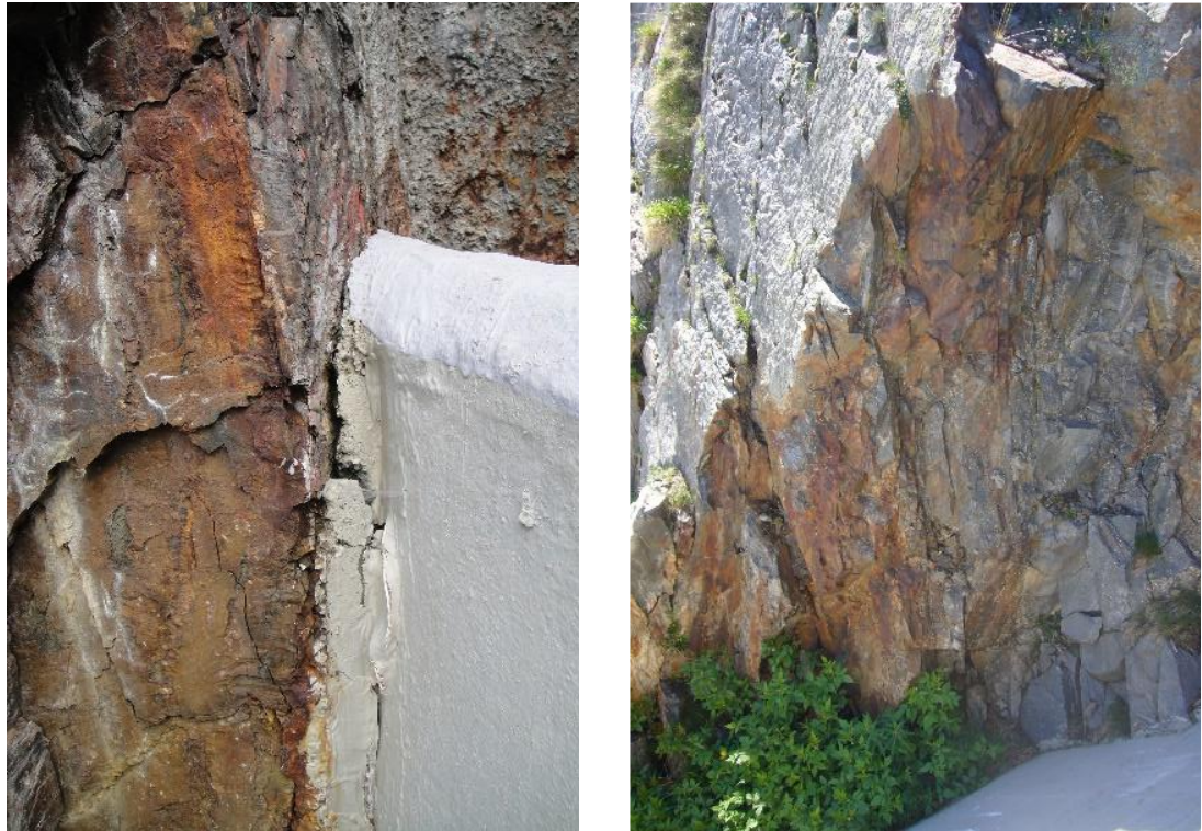
Figuras 4.31 y 4.32. Evidencias de oxidación de sulfuros de hierro en la roca de los estribos (cortesía A. Aguado)
