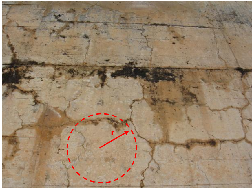
Figura 4.11. Círculo inscrito en retícula de fisuras en mapa (cortesía UPC)
