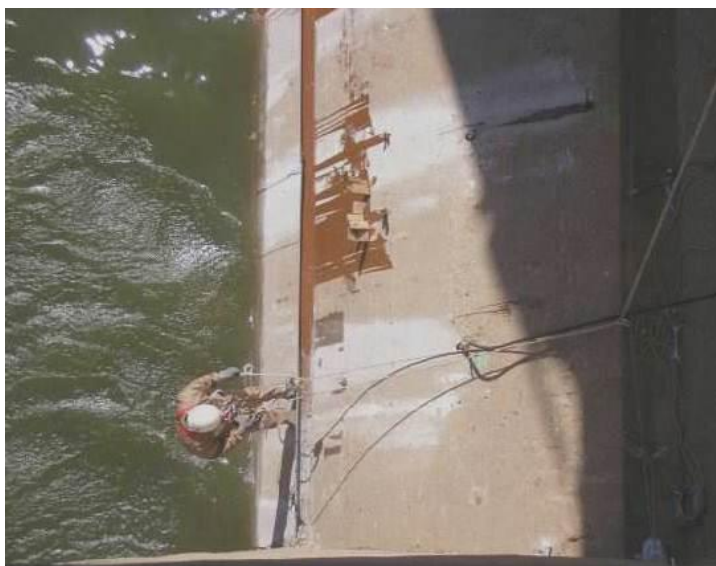
Figura 7.25a. Inyección de resina en un aliviadero (cortesía de Iberdrola)
