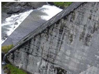
(j) Presa de Santeetlah (Atlanta) 2013
