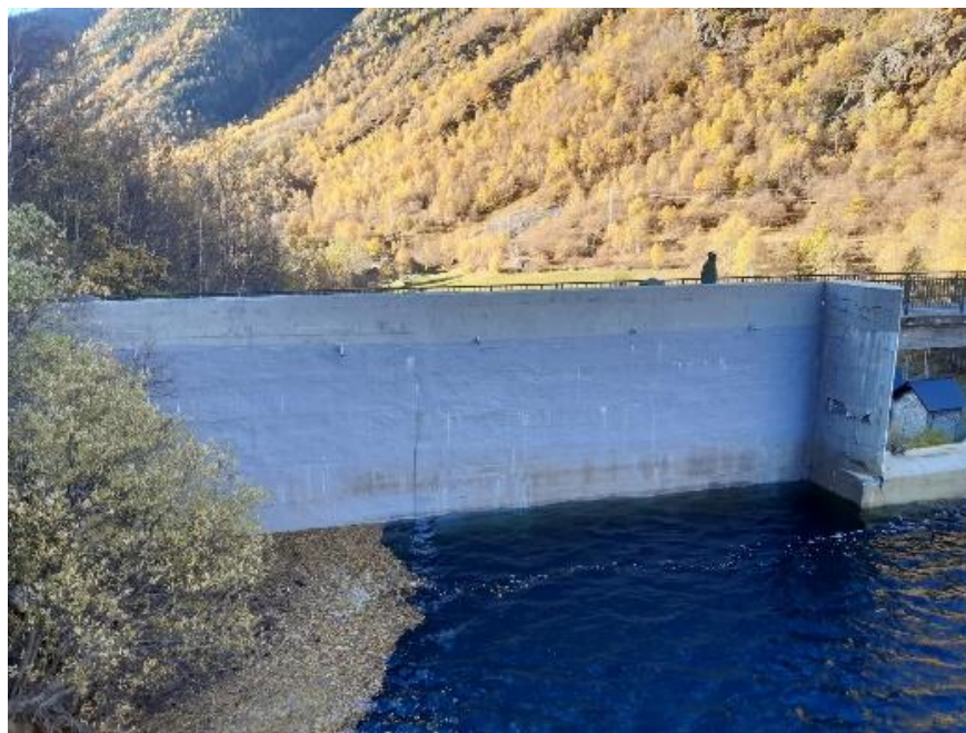
Figura 7.28. Impermeabilización de paramento de aguas arriba mediante sistema adherido (cortesía de Endesa)
