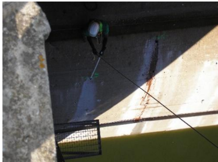
Figura 7.36. Anclajes de acero corrugado pasivado y de fibra de vidrio previos a la inyección (cortesía de Iberdrola)
