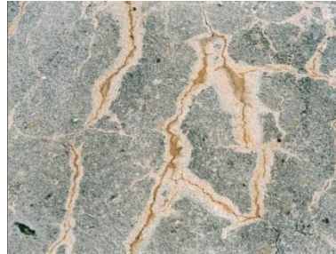
(e) Presa de San Esteban 2018
