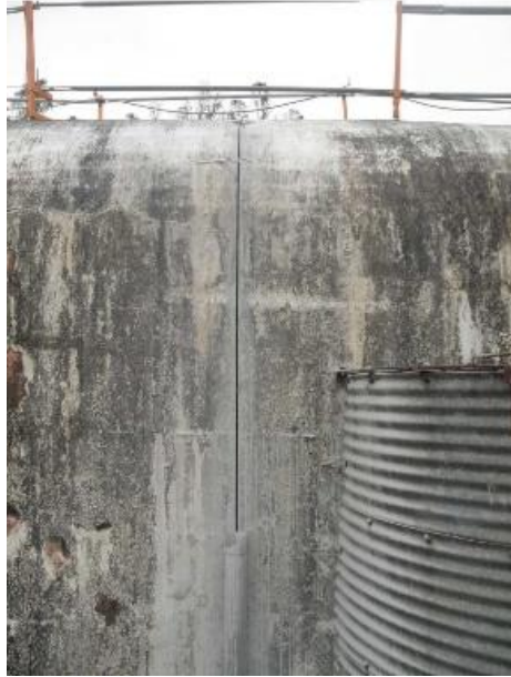
Figura 7.34a. Corte del hormigón en paramento de presa (cortesía de Naturgy)
