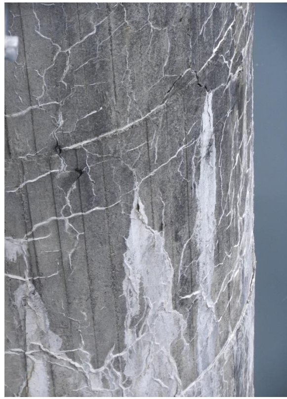
Figura 4.45. Lixiviación y reacción álcali-sílice (cortesía de E. Menéndez)
