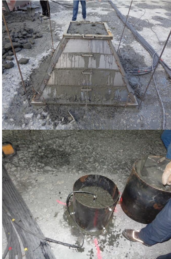
Figura 7.4c. Hormigonado de una roseta de extensómetros y extensómetro corrector (cortesía de Iberdrola)
