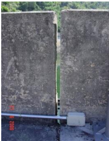
Figuras 4.23 y 4.24. Abertura de juntas entre tramos de pretil en alzado y en planta (cortesía de Iberdrola)
