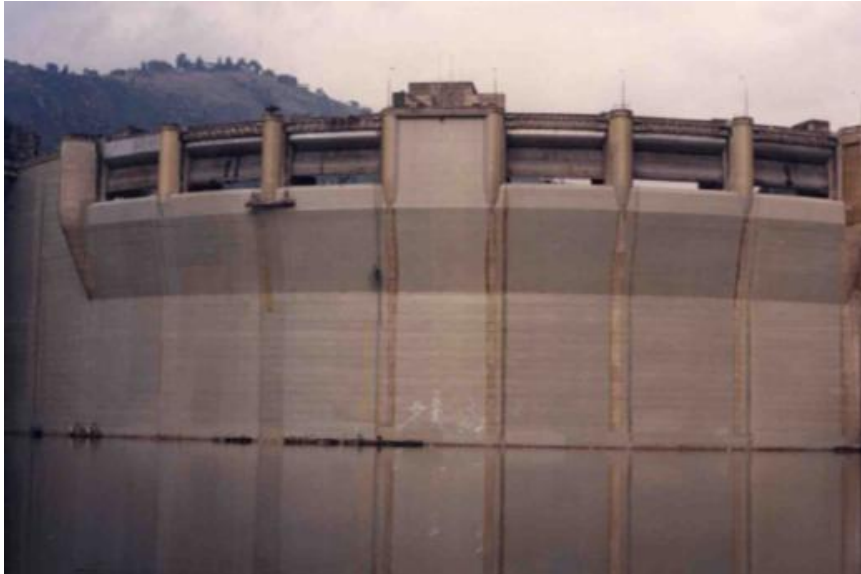
Figuras 7.26 y 7.27. Impermeabilización de paramento de aguas arriba mediante sistema adherido (cortesía de Iberdrola)
