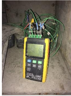
Figura 7.13. Lector de temperaturas (cortesía de Iberdrola)
