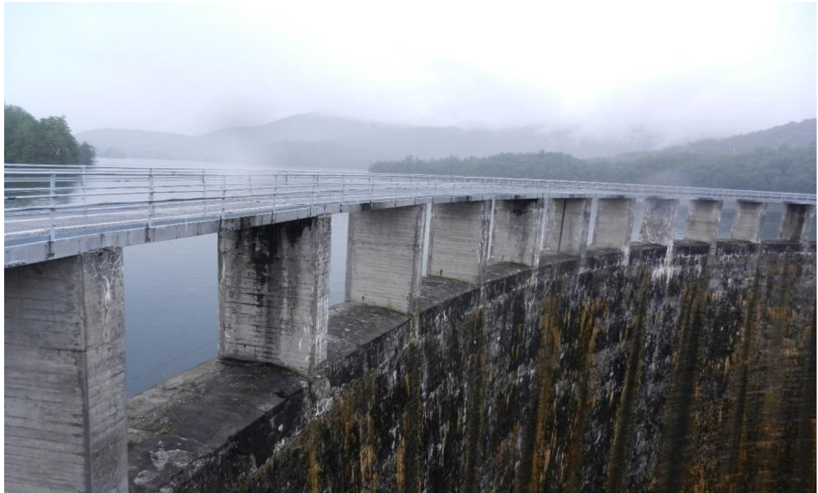
Figura 4.43. Combinación de fenómenos: lixiviación y ataque interno por sulfatos (cortesía de E. Menéndez)
