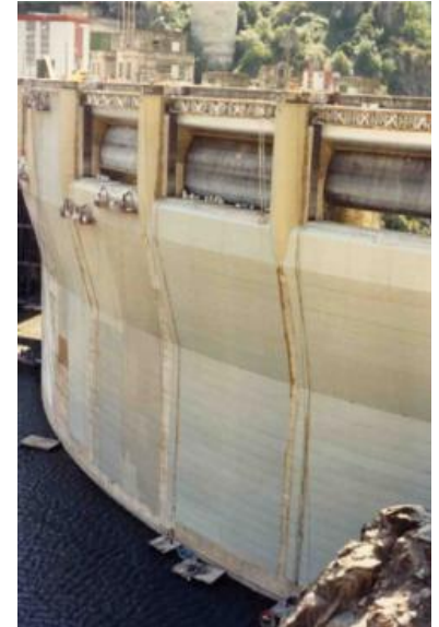
Figuras 7.26 y 7.27. Impermeabilización de paramento de aguas arriba mediante sistema adherido (cortesía de Iberdrola)
