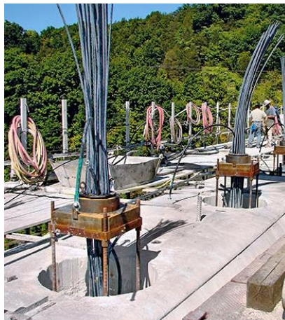
Figura 7.35a. Anclajes activos en presa ( https://www.dywidag-formties.com/ Accessed 2022/01/17)
