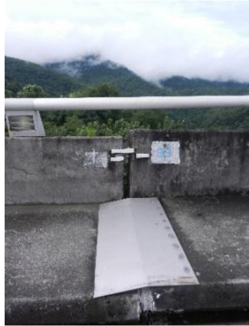
Figura 7.34b. Corte de relajación en presa finalizado. Coronación (Cortesía de E. Menéndez)
