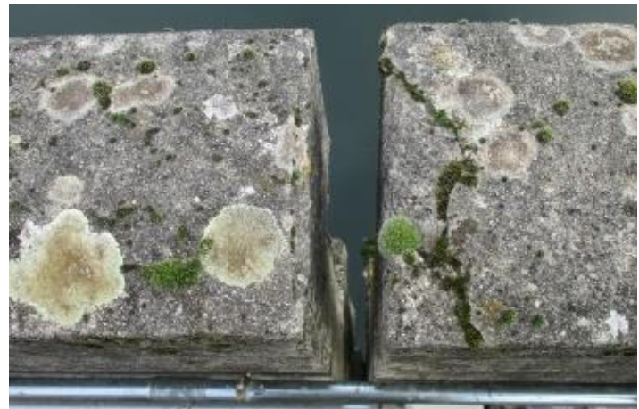
Figuras 4.23 y 4.24. Abertura de juntas entre tramos de pretil en alzado y en planta (cortesía de Iberdrola)
