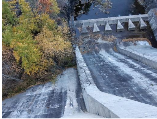
Figura 7.35b. Anclajes pasivos en los cajeros de un aliviadero para contener la deformación por expansión (cortesía de Endesa).
