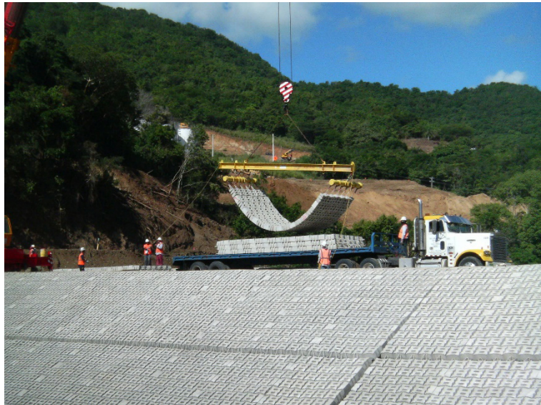
Fig. 29. Transporting Armorflex Block Blankets™ to the cofferdam of the El Portugués Dam (DRAGADOS)
