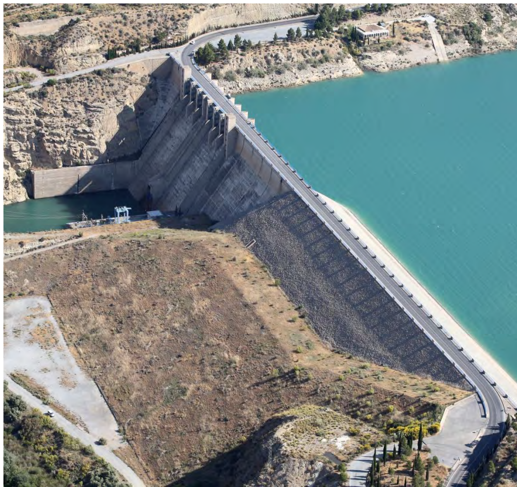
Presa del Negratín
