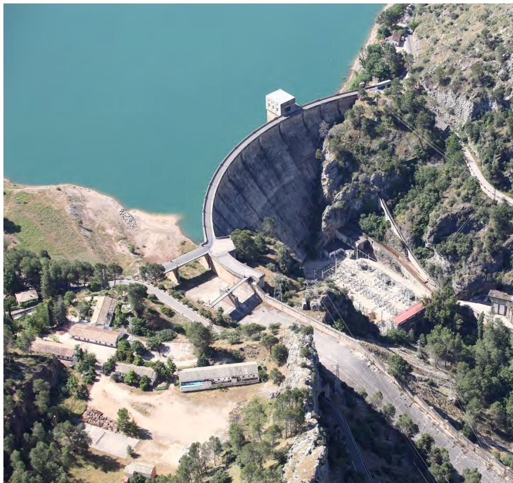
Presa de Tranco de Beas
