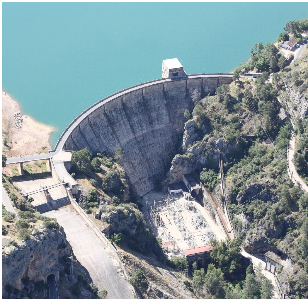
Presa de Tranco de Beas
