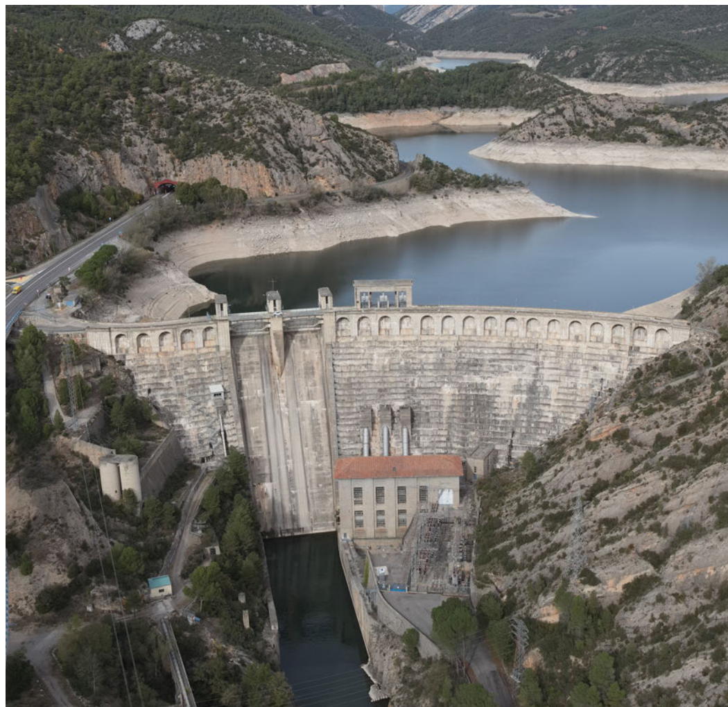
Presa de Oliana
