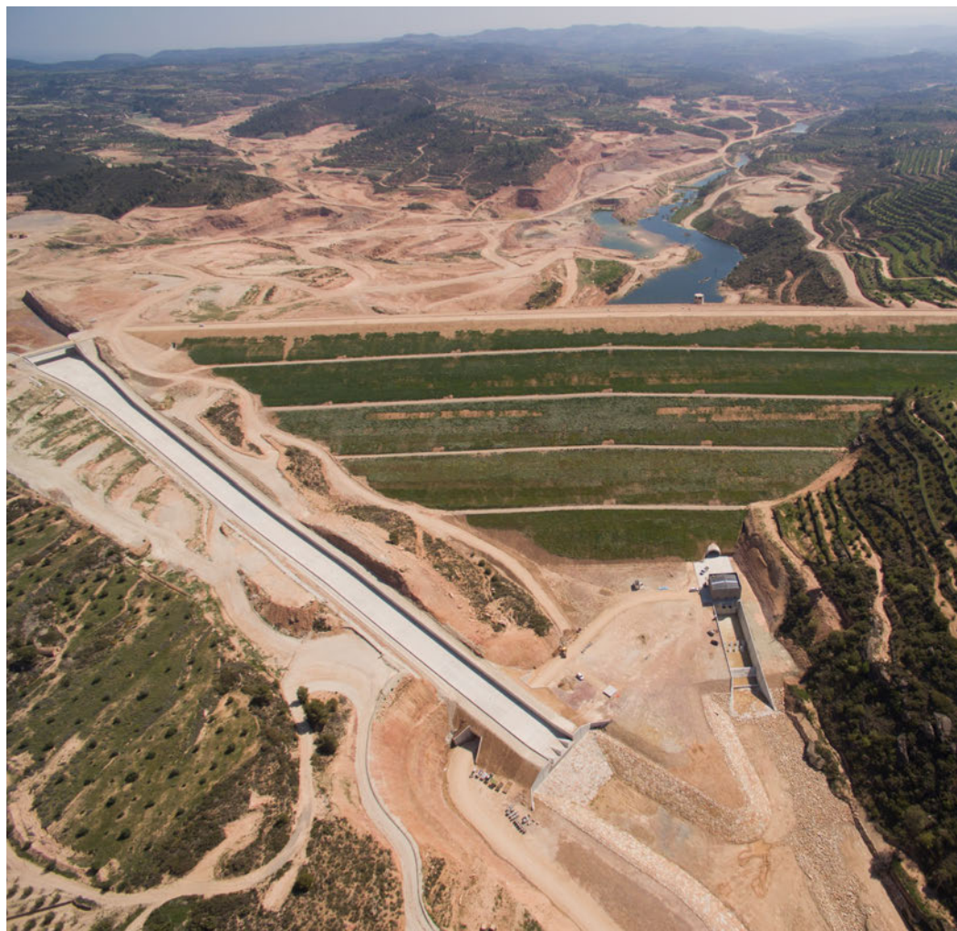
Presa de Albagés
