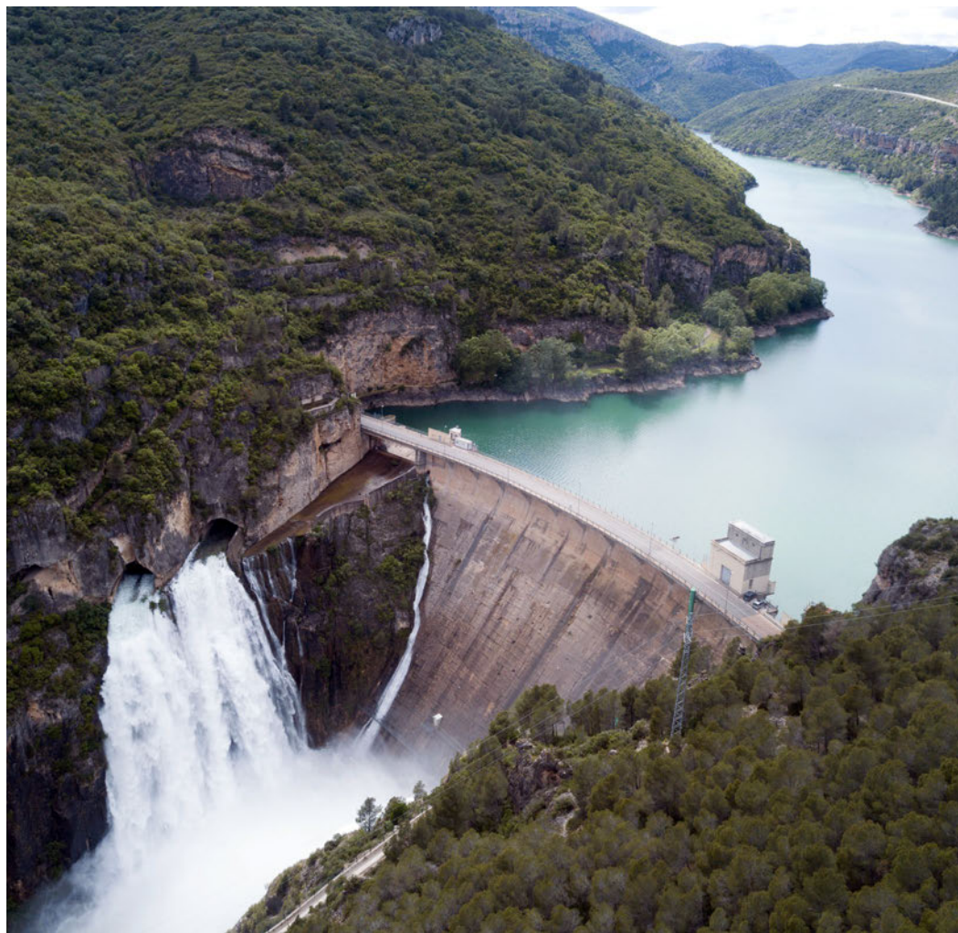
Presa de Camarasa
