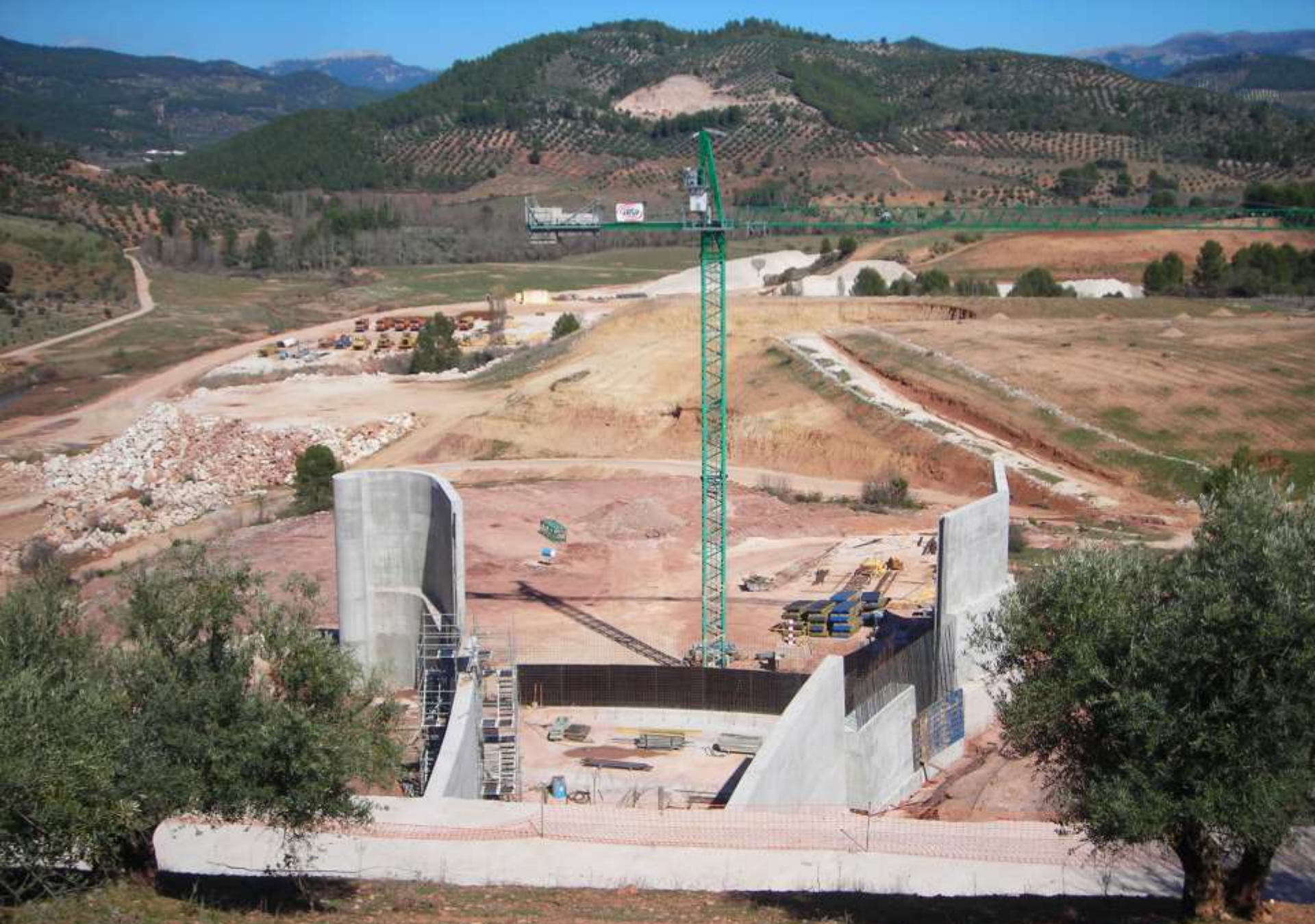
Dirección Gral. del Agua – C. H. Guadalquivir – Presa de Siles
