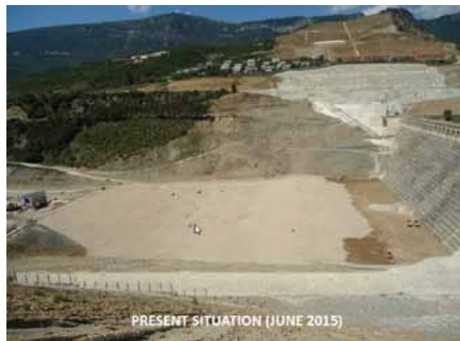
Fig. 15. Vista general de la estabilización (junio 2015)
