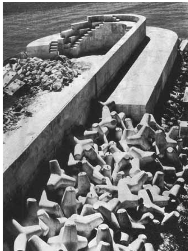
Base Naval de Rota. Rompeolas de Tetrapodos. Fuente: SPANCOLD
