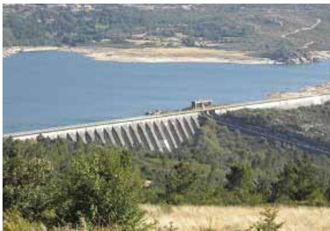
Fig. 8. Presa de Salas
