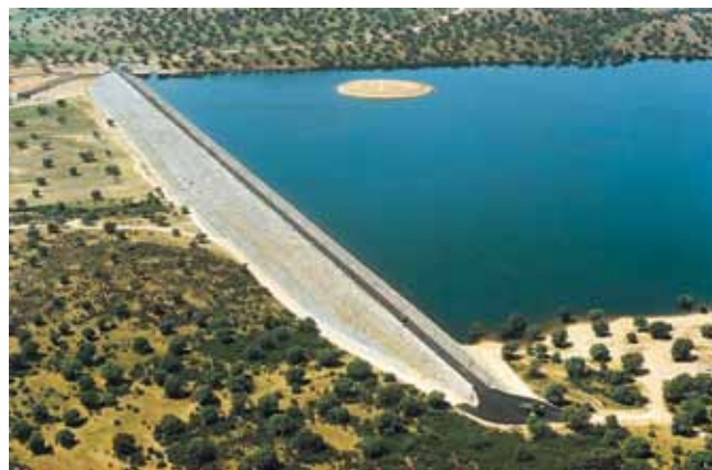
Presa de Cubilar
