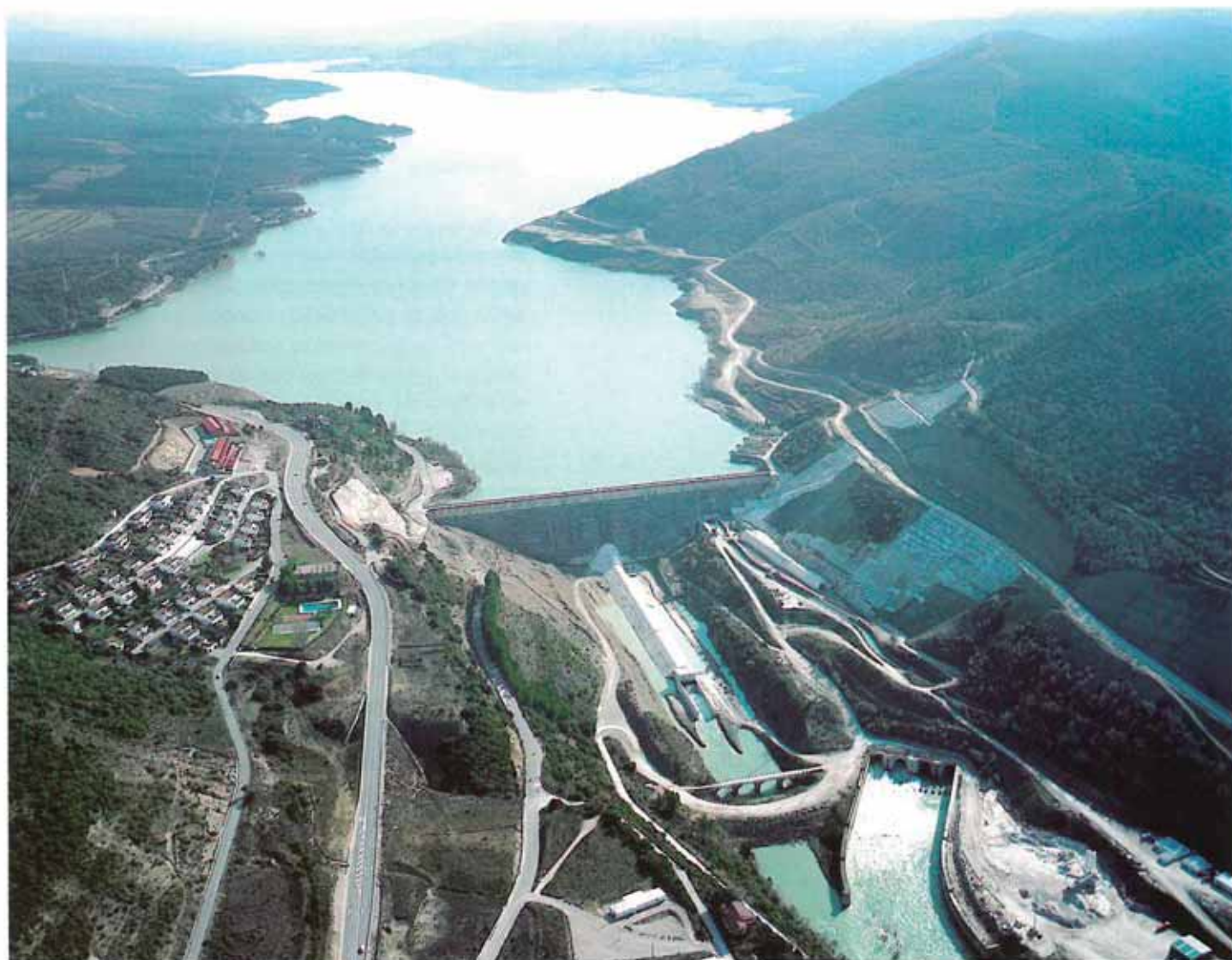
Fig. 1. Recrecimiento de la presa de Yesa. Vista general de las obras.
