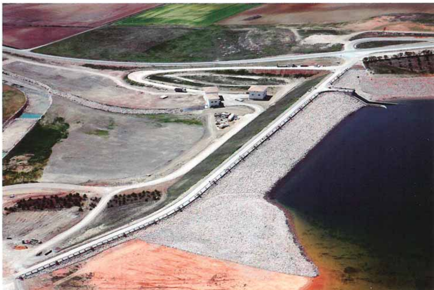
Fig. 10. Vista aérea de la presa.
