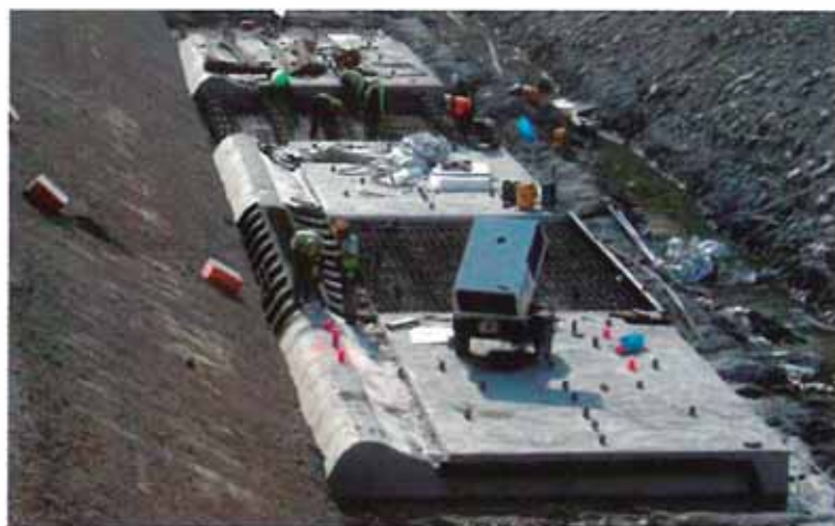
Fig. 15. Construcción del plinto en la presa de Terroba. Incluiría por Lafuente et al. en la R27.
