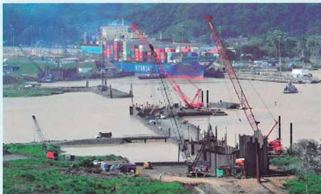
Fig. 29. Presa de Borinquén I E (PAC-4). Ejecución de los cofferdams.
