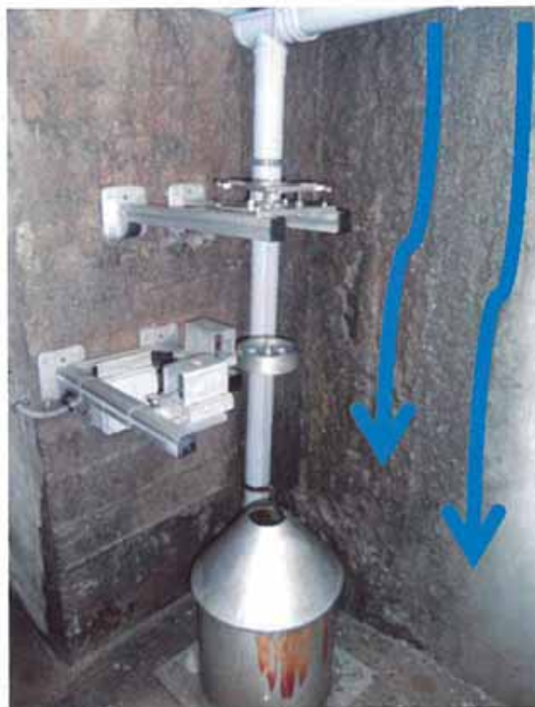
Fig. 10. Caida de agua a través de un péndulo directo, incluida por Gil, Arguedas y G. Membrillera, en la R26.
