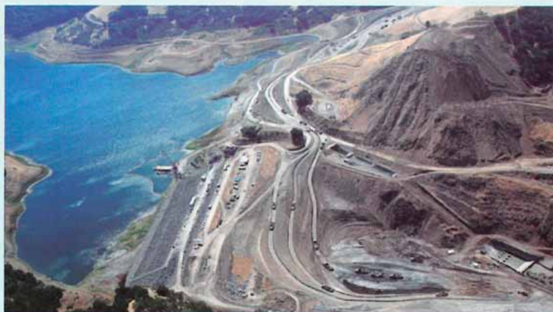
Fig. 17. Presa de Calaveras Vista aérea de los trabajos.
