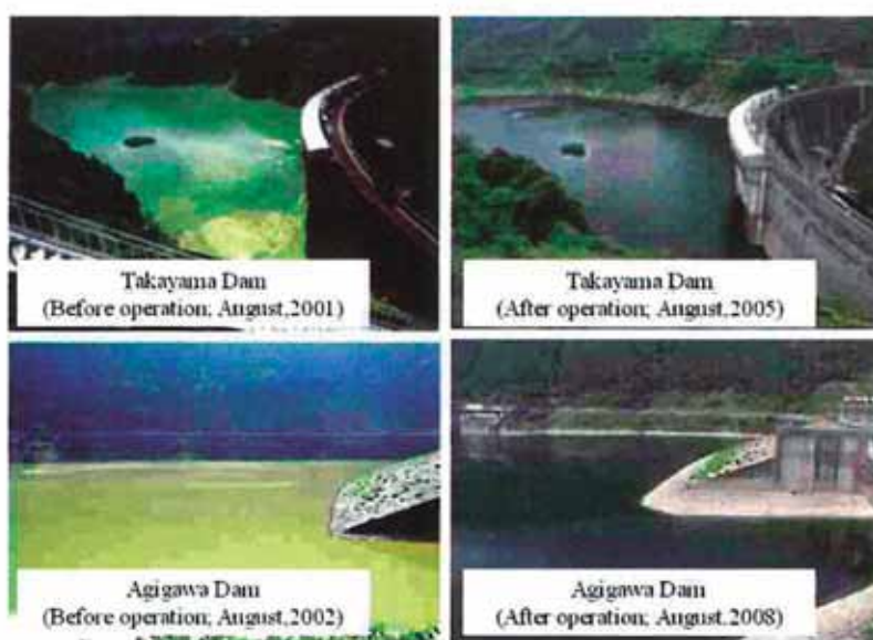
Fig. 4. Embalses de Takayama y Agigawa antes y después de la operación de aireación.
