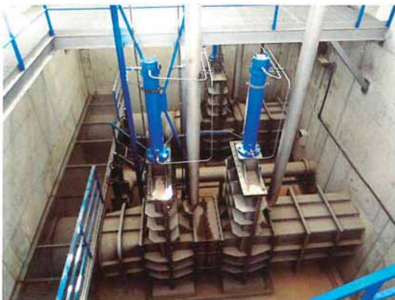
Fig. 7. Caseta de desagüe.
