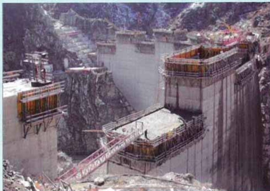
Fig. 12 Presa de Tsankov Kamak durante la construcción.
