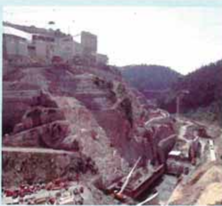
Fig. 19. Presa de Ribeiradio. Aspecto de la excavación e inicio del hormigonado.
