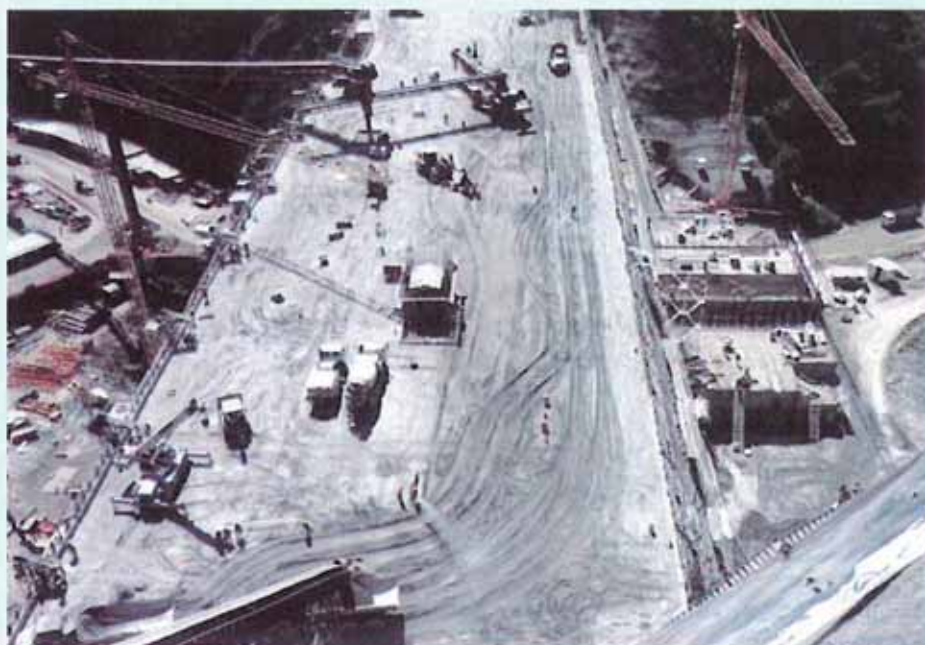
Fig. 36. Vista de la presa durante su construcción.
