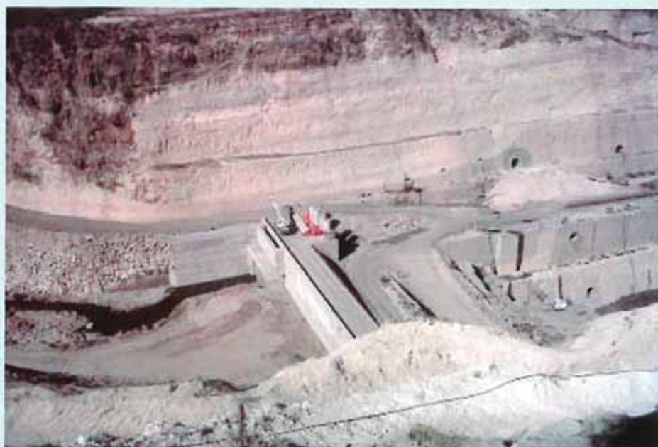
Fig. 32. Presa de El Zapotillo. Atagüía para el desvío del río Verde y losa de prueba.
