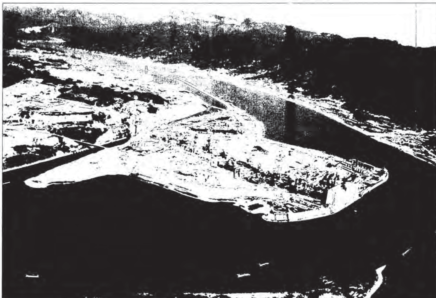
Foto 3: Vista de la presa en construcción desde aguas arriba. Por la derecha fluye el Yangtze en la segunda fase de su desvío; se construye en el recinto central al amparo de ataguías de 72 metros de altura, la central izquierda de pie de presa y la zona de aliviaderos; a la izquierda se construyen las estructuras de navegación. Abajo, foto 4: Cuerpo de presa en construcción (septiembre 2000)
