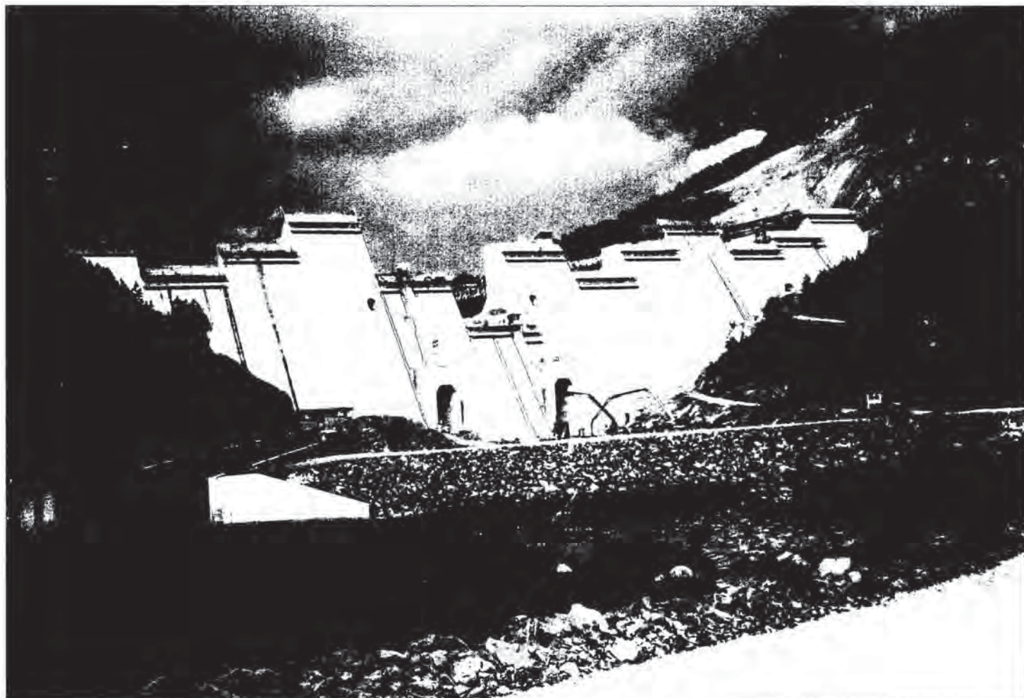
Figura 12. Contraatagüa y canal del desvío.
