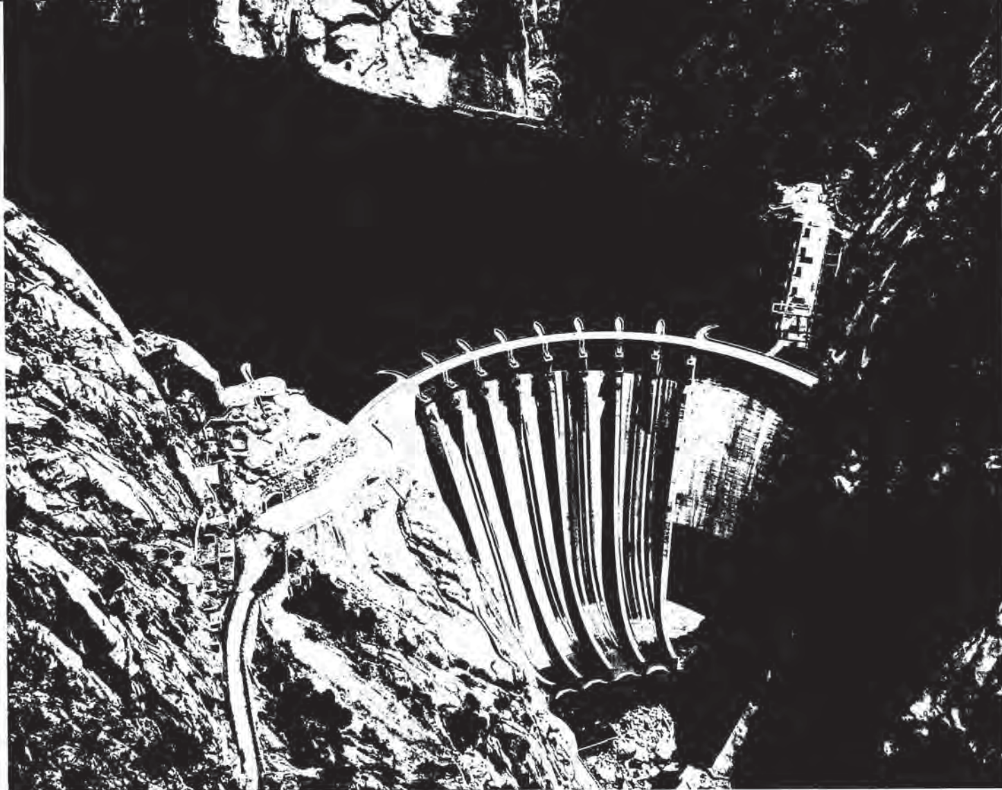
Presa de Aldeadávila. Objetivo: Generación eléctrica.
