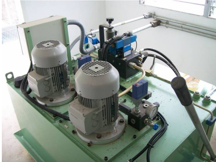
Figura 5.24. Unidad de accionamiento de la válvula de regulación
