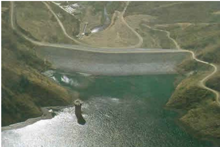
Figura 3.5. Presa de Camatagua, acueducto metropolitano.
