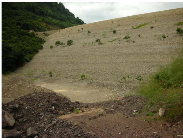
Figura 5.16. Aspecto del espaldón de aguas abajo
