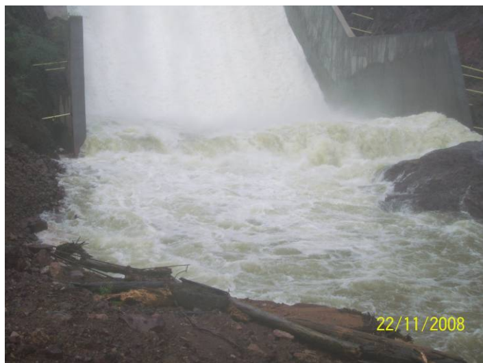
Figura 5.67. Erosión durante el alivio
