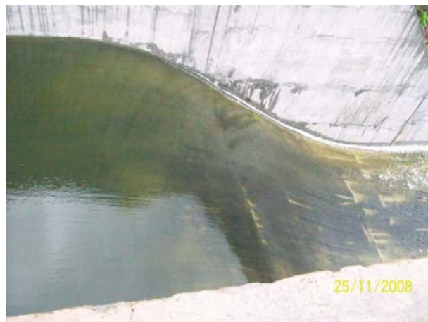
Figura 5.49. Flujo sobre el vertedero
