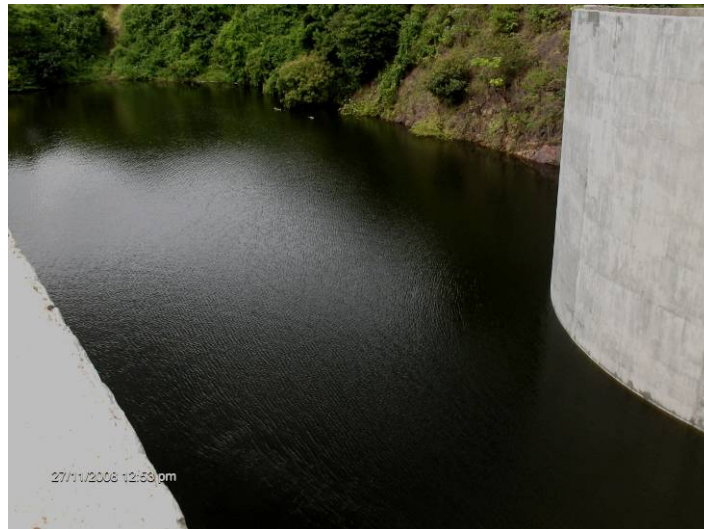
Figura 5.32. Aproximación del flujo a la embocadura
