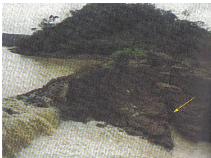
Figura 3.8. Presa El Cristo durante su rotura, (Suárez L., 2002 [6])
