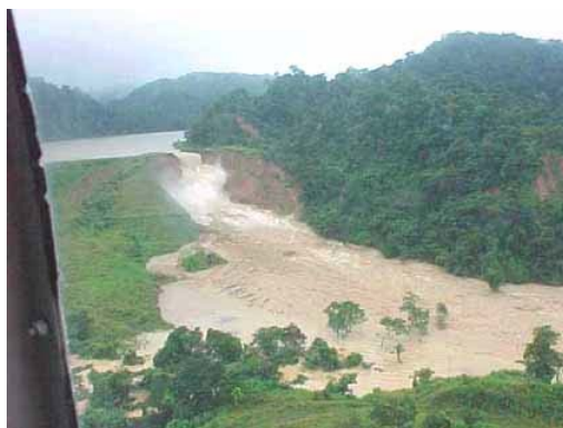
Figura 3.10. Vaciado del embalse a través de la brecha
