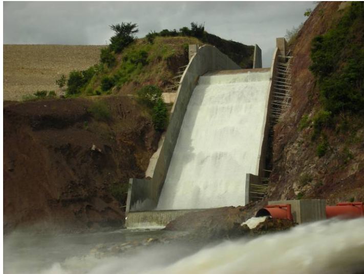
Figura 5.22. Vista frontal del aliviadero
