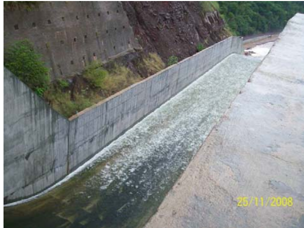
Figura 5.50. Canal de baja pendiente (MINAMB, Nov. 2008)
