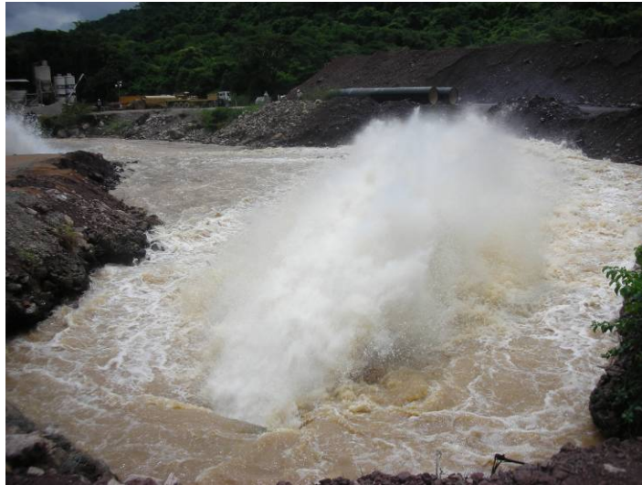
Figura 5.62. Descarga de fondo en condiciones actuales
