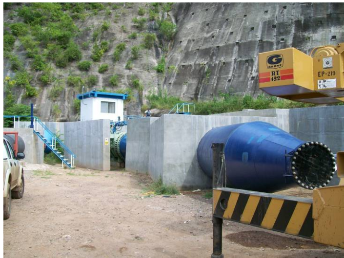
Figura 5.64. Descarga adicional antes de su primera apertura
