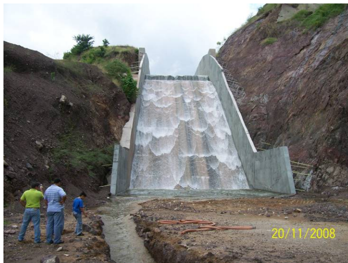
Figura 5.66. Estanque disipador al inicio del alivio
