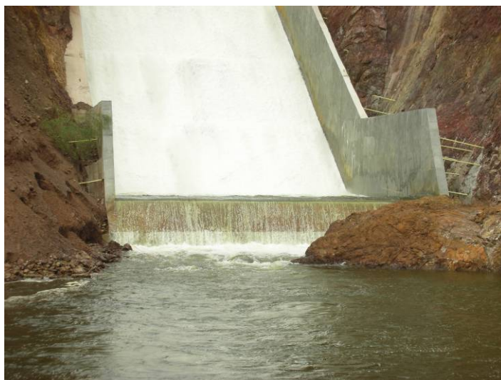
Figura 5.68. Estado final del estanque disipador
