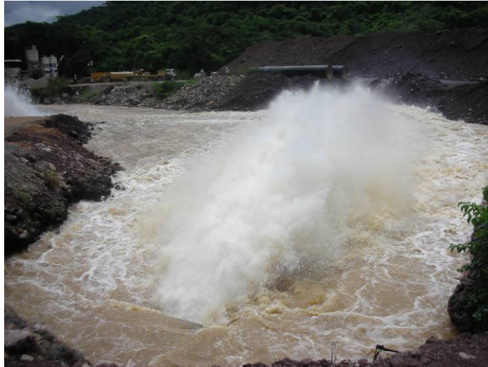
Figura 5.8. Descarga de fondo en condiciones actuales
