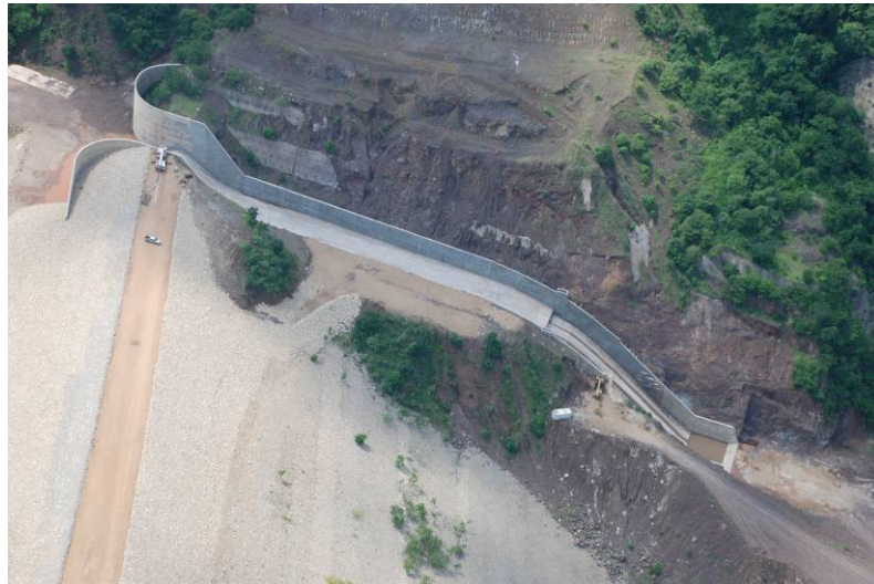
Figura 5.74. Acceso al aliviadero desde la coronación
