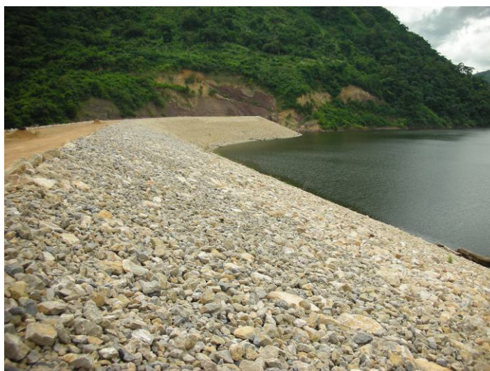
Figura 5.17. Aspecto del espaldón de aguas arriba.
