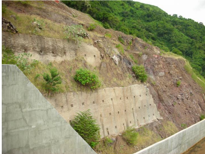
Figura 5.14. Aspecto del estribo izquierdo.
