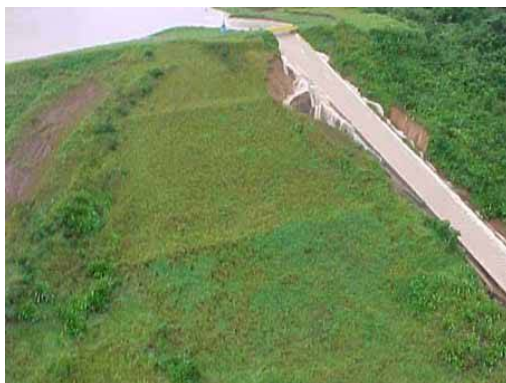
Figura 3.9. Inicio del desborde del canal rápido del aliviadero.
