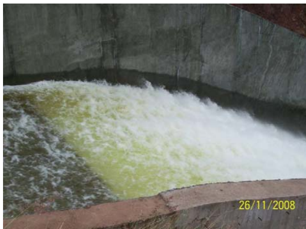
Figura 5.55. Aireador en funcionamiento (MINAMB, Nov. 2008)
