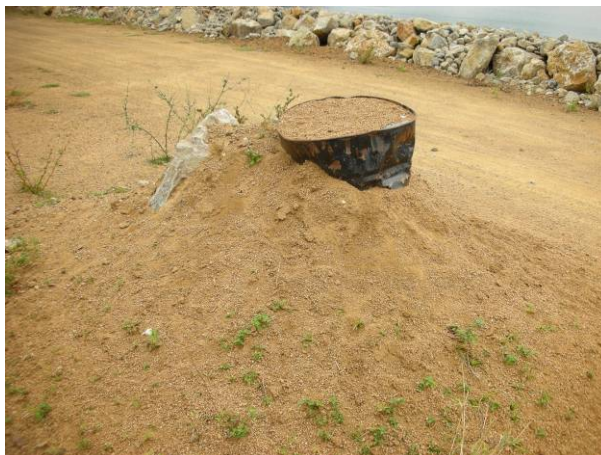
Figura 5.18. Protección de los cables de piezómetros
