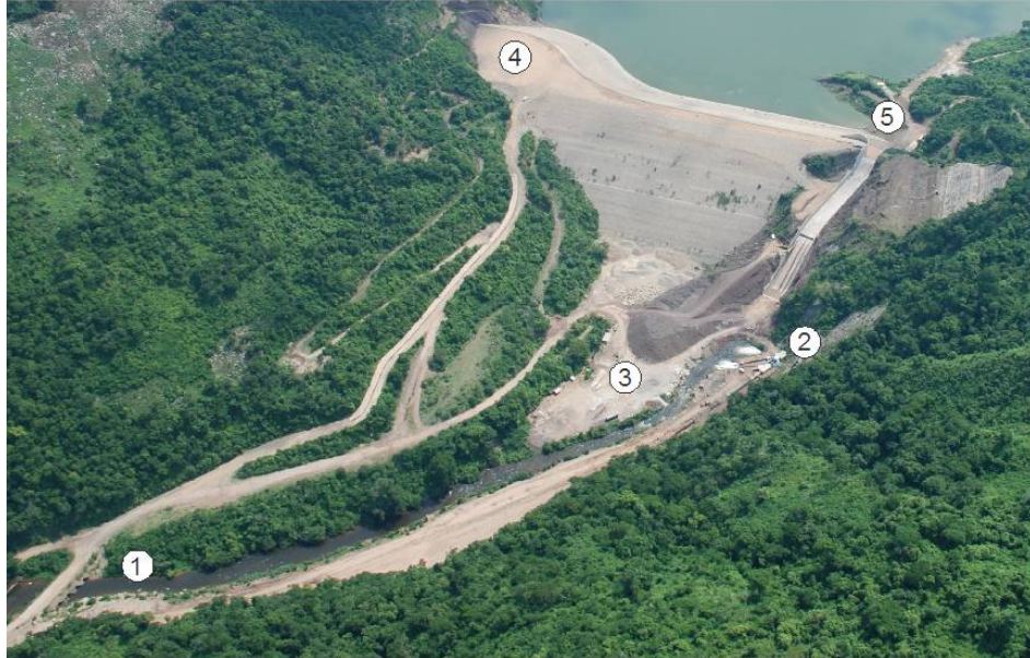
Figura 5.73. Vista aérea de la vialidad
