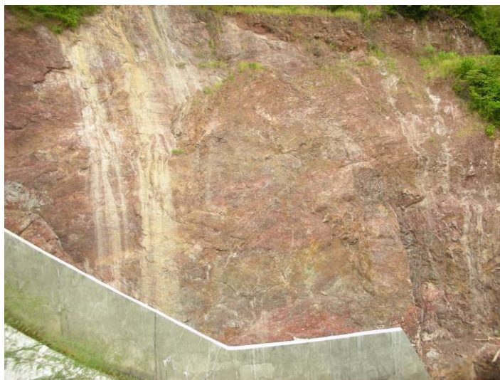
Figura 5.15. Estribo izquierdo sobre el rápido del aliviadero
