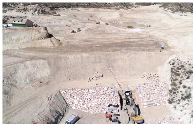
Ilustración 6: Foto a vista de dron de dique de cierre principal, galería visible y trabajos de terraplenado con traíllas.
