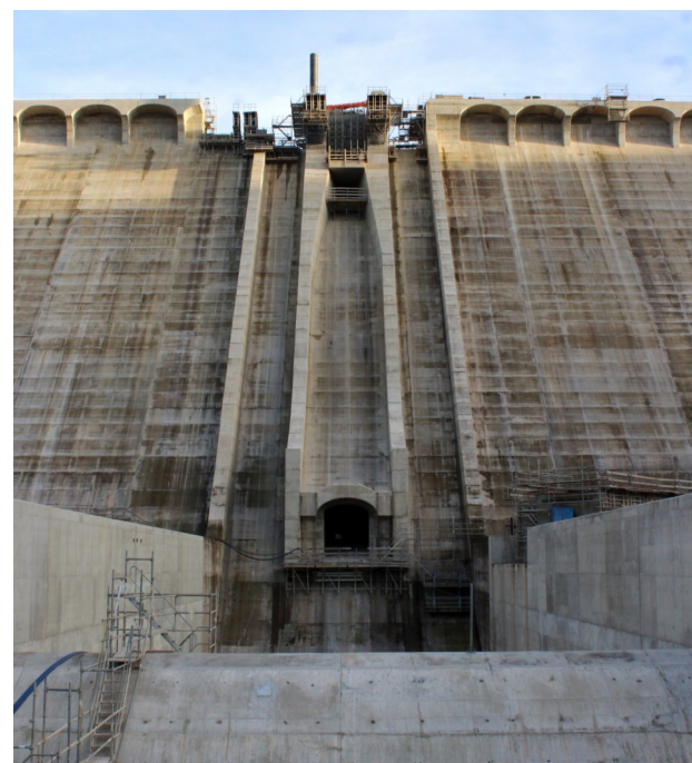
Figura 4: Vista de aguas abajo de la zona central de la presa
