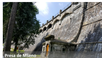
Presa de Mšeno
