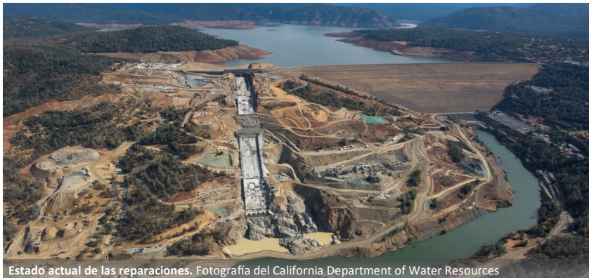
Estado actual de las reparaciones. Fotografía del California Department of Water Resources
