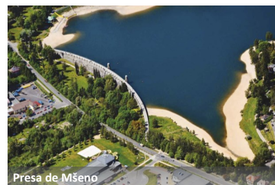
Presa de Mšeno
