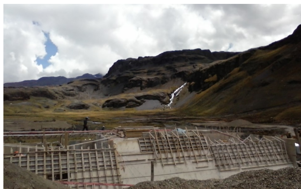
Represa de Hampaturi Alto, en construcción (10/01/2017)
