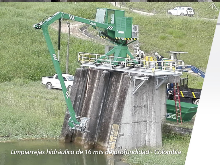
Compuertas Radial de 14,5 x 8 mts – Guatemala
