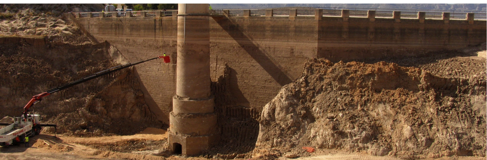
ACONDICIONAMIENTO DE LA PRESA DE ALMANSA (ALMANSA, ALBACETE)
