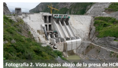
Fotografía 2. Vista aguas abajo de la presa de HCR
