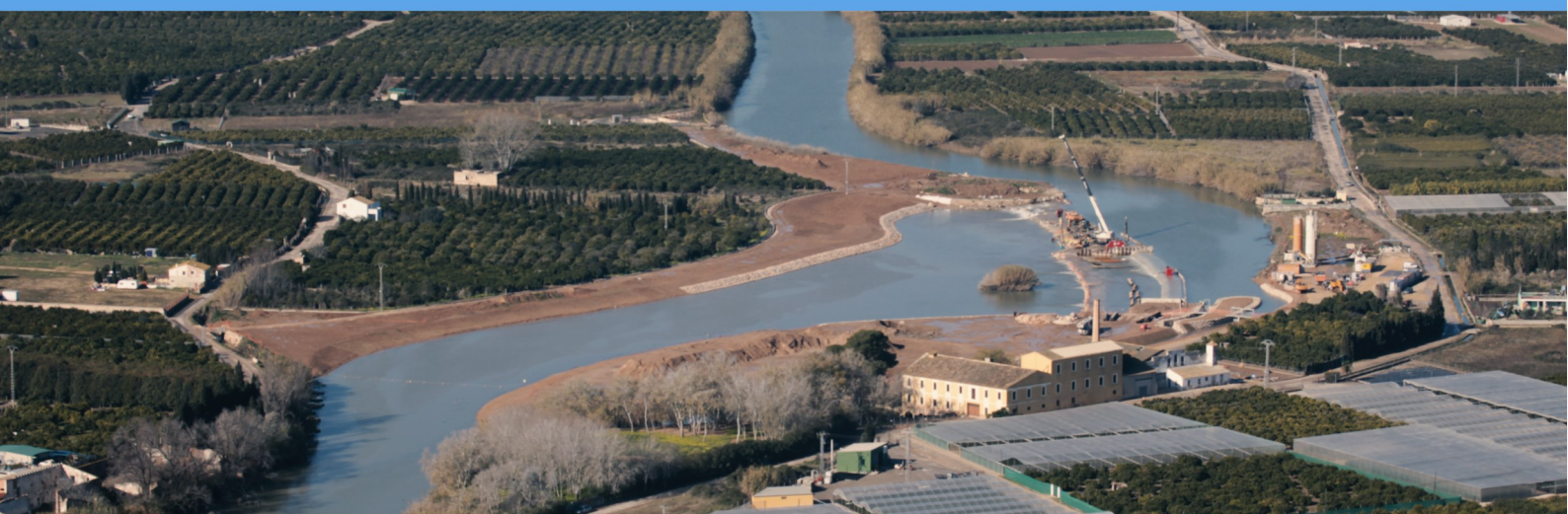
RECONSTRUCCION DEL AZUD DE LA MARQUESA (CULLERA, VALENCIA)
