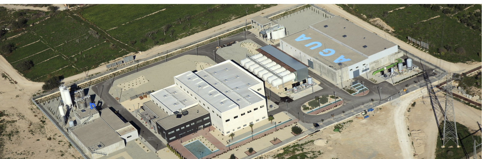
CONSTRUCCION DE LA DESALADORA DE LA MARINA BAJA (MUTXAMEL, ALICANTE)
