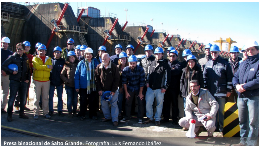
Presa binacional de Salto Grande. Fotografía: Luis Fernando Ibáñez.
