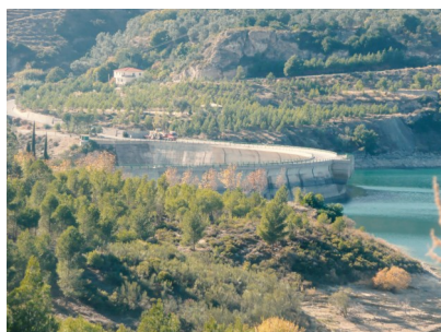
Presas de Bézner en el río Izbor, Granada. Bóveda de doble curvatura (Fuente: http://eselagua.com )
