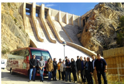
Presa de Contreras.
