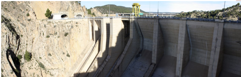
Presa de Contreras.
