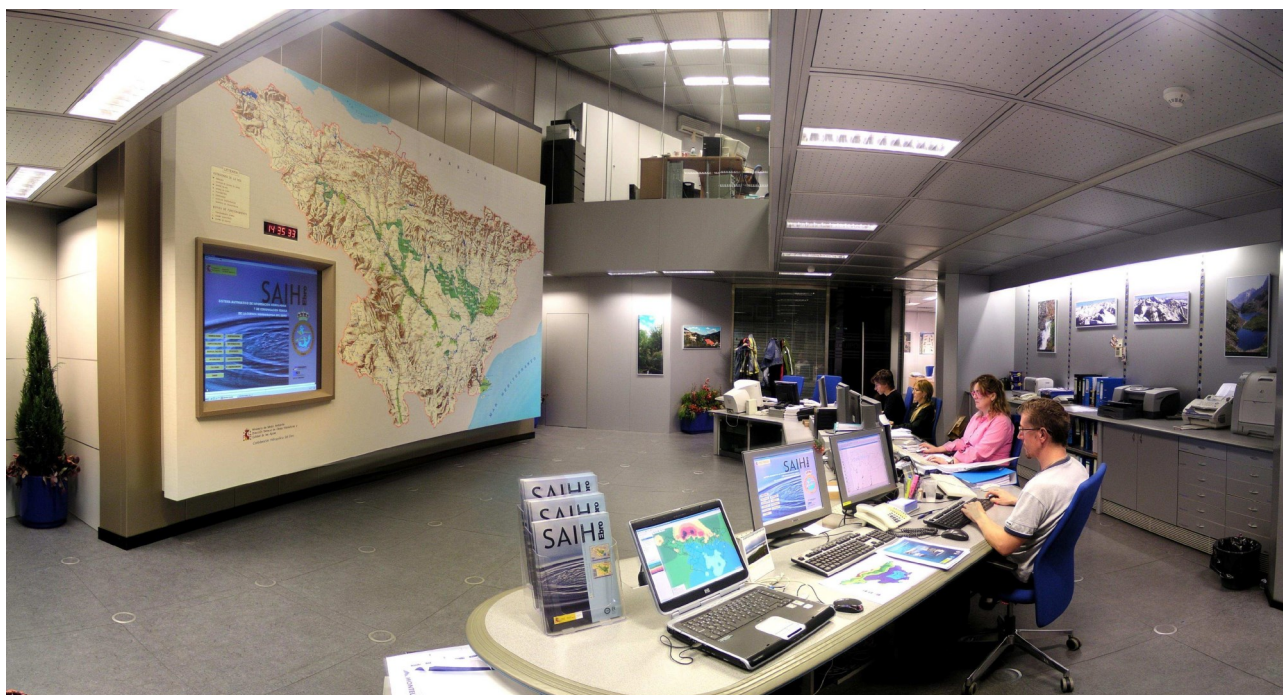
Ilustración 9: Centro de control del SAIH del Ebro.
