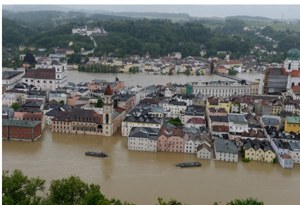
Ilustración 1: Inundaciones en el año 2013 en Alemania. Unión de los ríos Inn y Danubio. Passau (Bavaria). Se aprecian los calados de inundación de varios metros.
