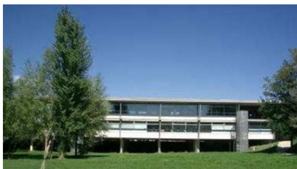
Ilustración 8: Edificio pilotado. Mediateca de Gardanne (Francia) adaptado a la inundación periódica.
