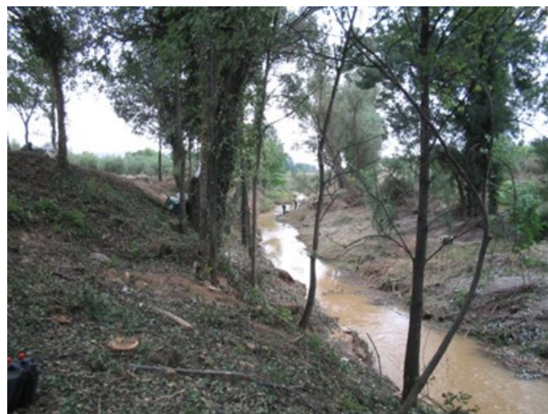
Ilustración 4. Estado del río Jalón (Ebro) antes y después de labores de mantenimiento y conservación, que mejoran el estado del cauce y las márgenes, retiran residuos, etc.. y se aumenta la capacidad de evacuación de las avenidas.
