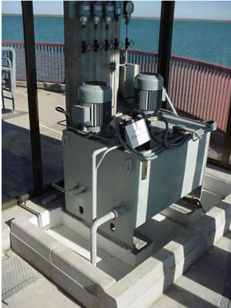
Fosos de contención de aceite Compuerta de toma
