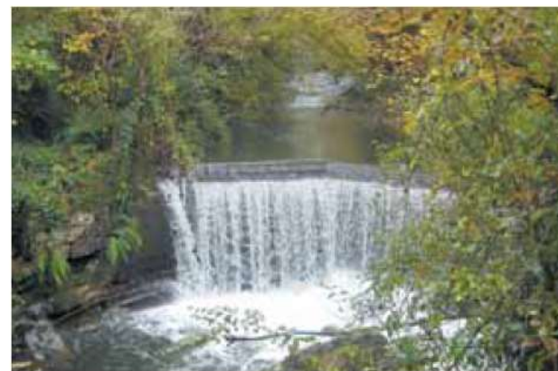
Imagen de la presa Errotaberri, en Elbete.
