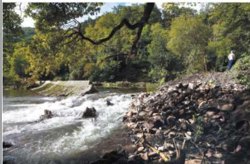
Aspecto que presentaba la grava de Bera o San Martín y por la tarde tras haber comenzado las obras de demolición de ésta.
