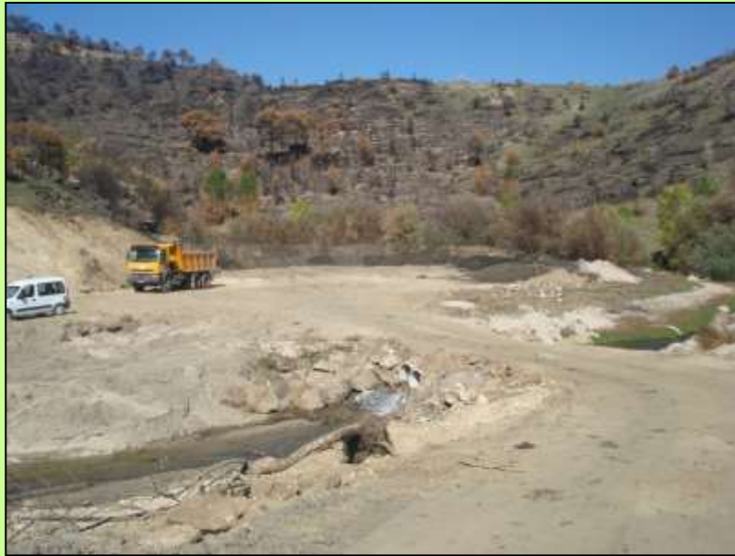
Ejecución de los trabajos
