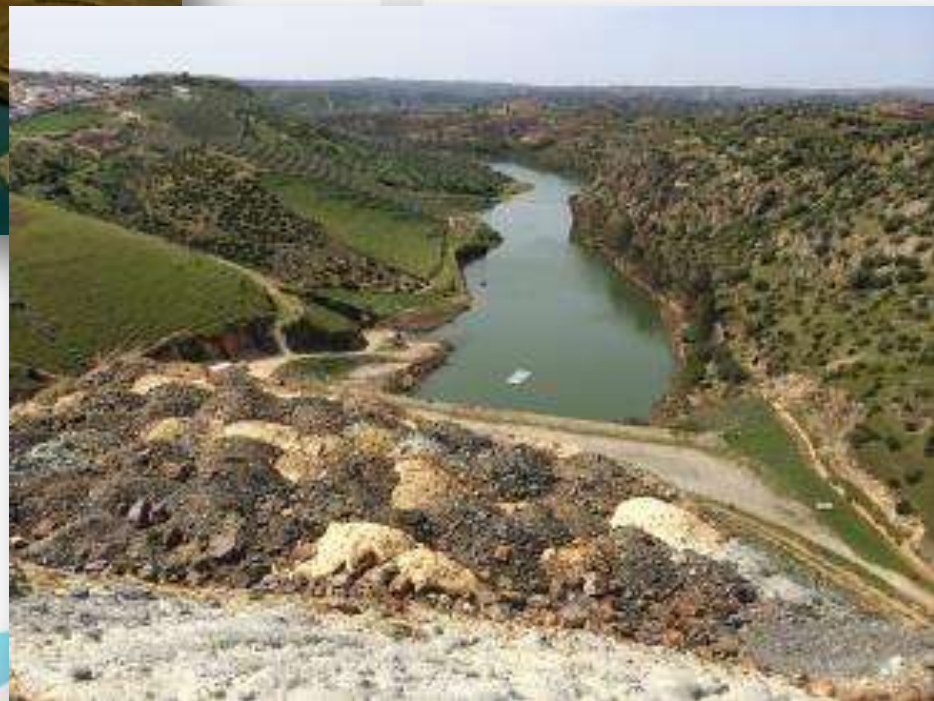
Vista hacia aguas arriba desde el vertedero (2014)
