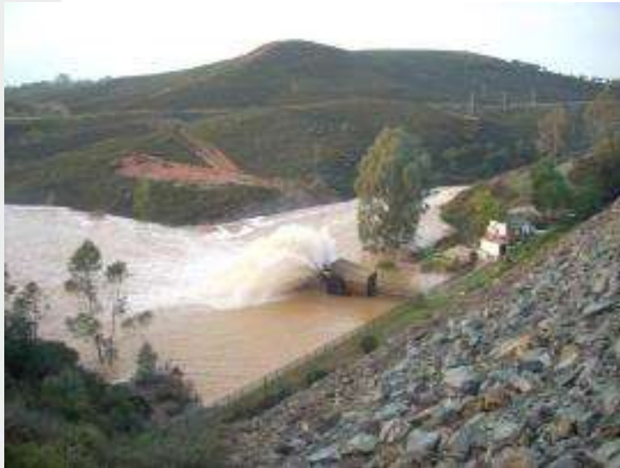
Desagüe de fondo, avenida 2010
