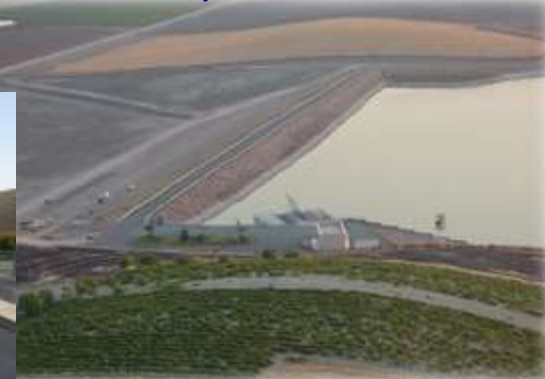
Vista aérea del dique nº1
