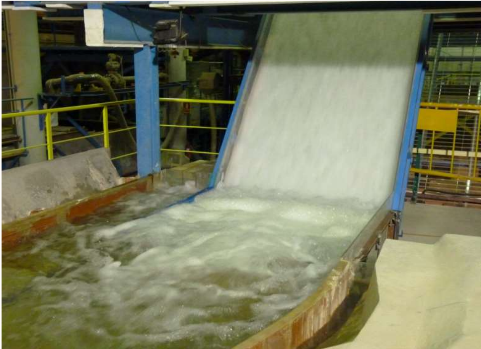
Avenida extraordinaria. Desagüe de fondo abierto
