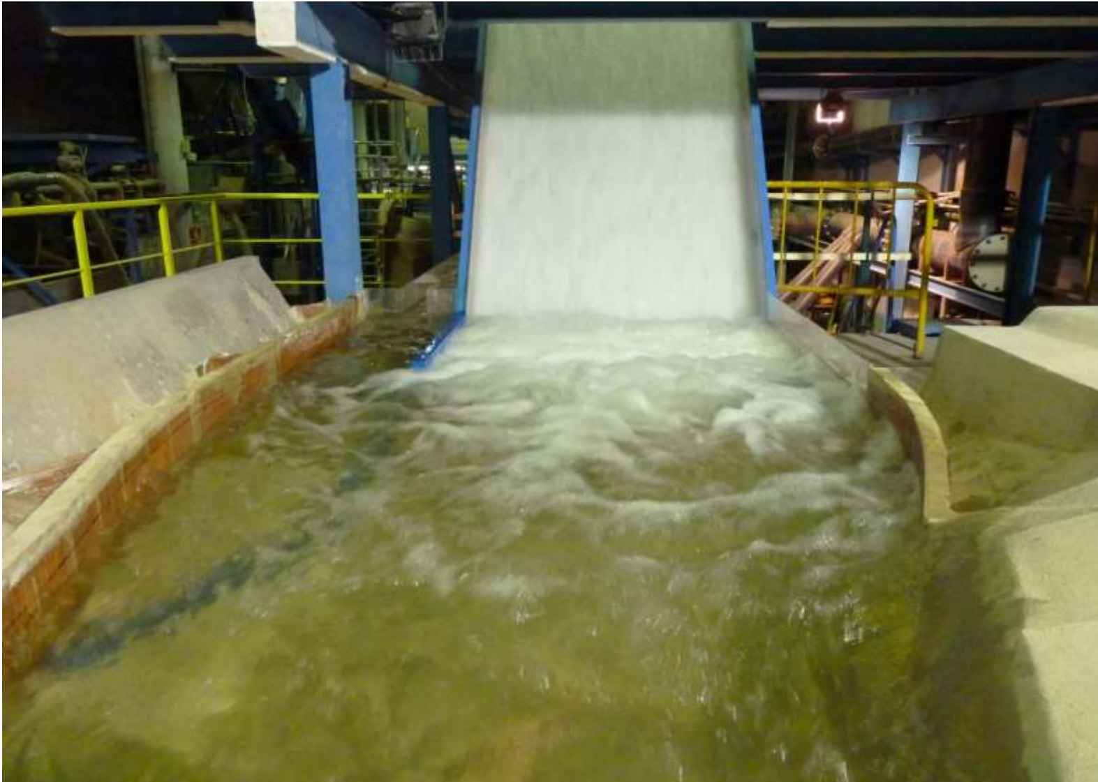
Avenida extraordinaria. Desagüe de fondo cerrado
