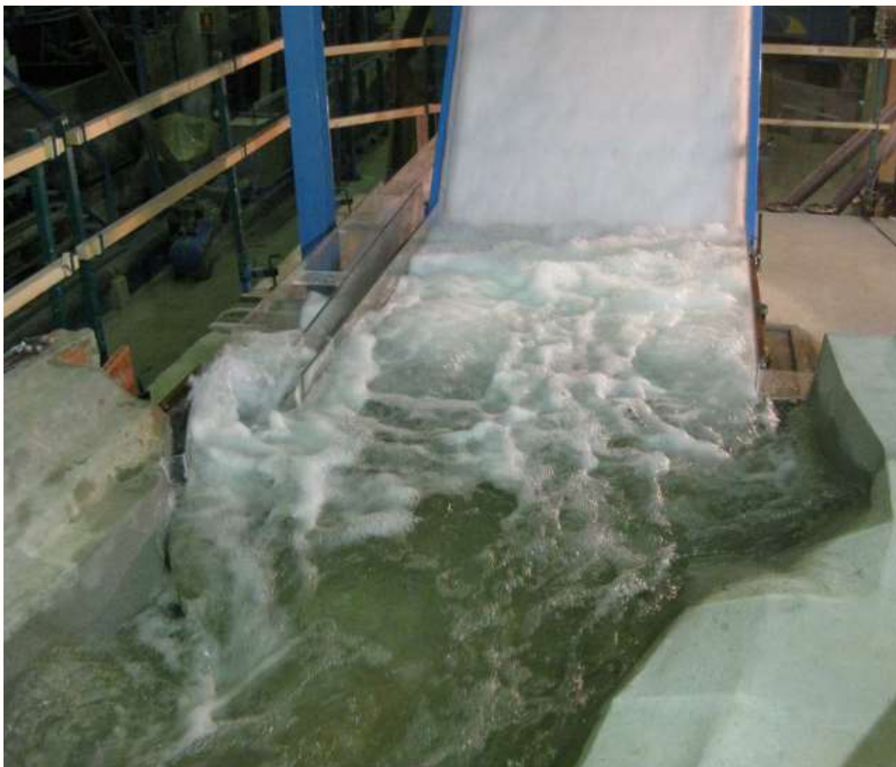
Desagüe de fondo abierto, avenida extraordinaria por el aliviadero
