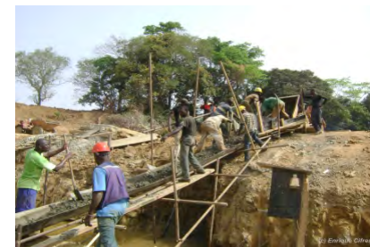
Hormigonado de la pequeña presa de M'Bahiakro en Costa de Marfil, para el regadío del arroz.
