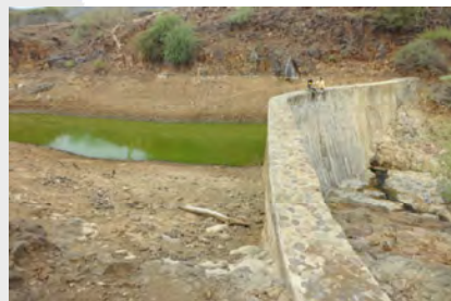
Presa de mampostería. Nariokótome. Turkana. Kenia.
