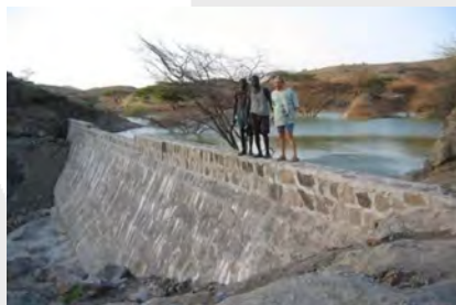
Presa de piedra en la zona de las montañas en Turkana, Kenya.
