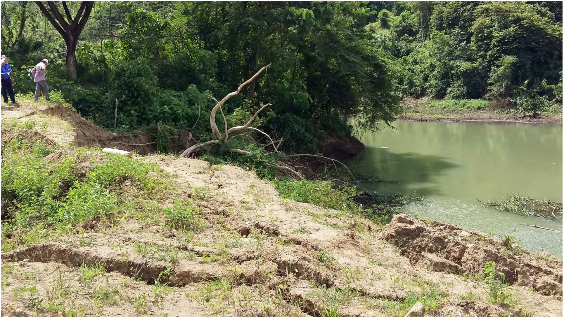
Fotografía de deslizamiento rotacional en la margen izquierda del río , aguas abajo de la presa
