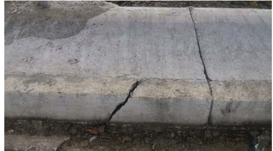
Acera de aguas abajo
