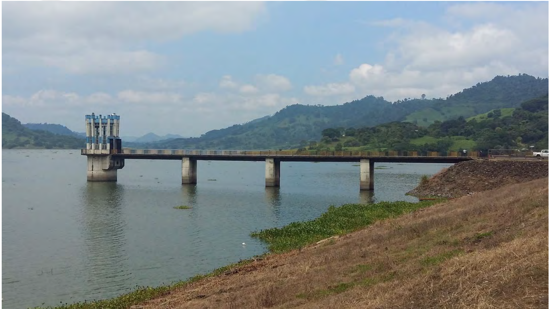
Fotografía del Puente de acceso a Torre de toma.
