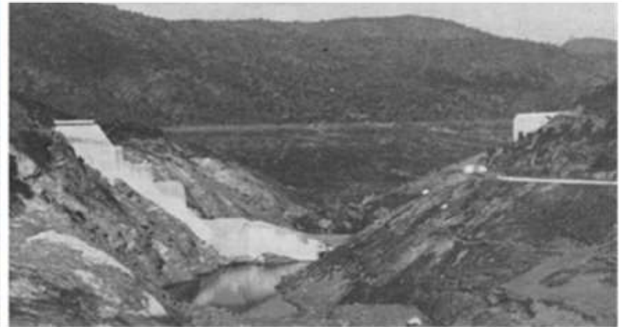
Después de la rotura 1959
