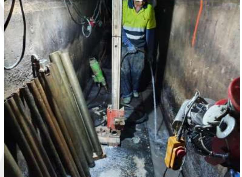
PRESAS DERIVACION VIÑUELA
