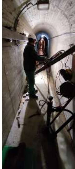
Perforación y colocación extensómetro
