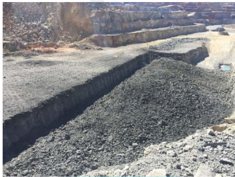
Pila de material volado (60.000 m 3 )
