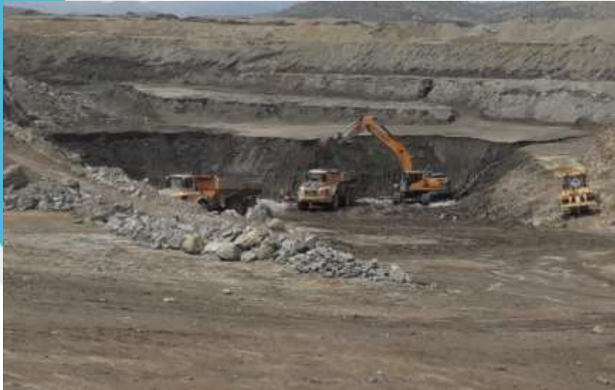
Mejora mediante saneo de terreno
