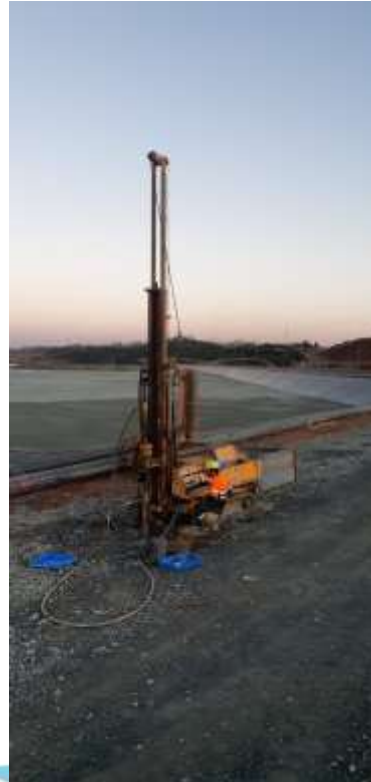
Perforación Inclínómetro.
