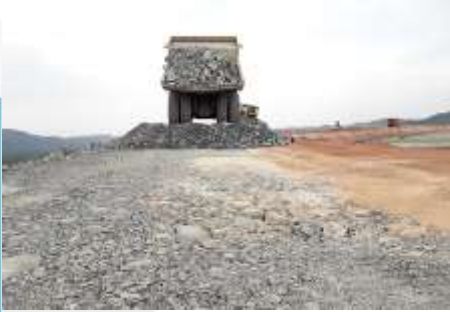
Ataluzado material de transición
