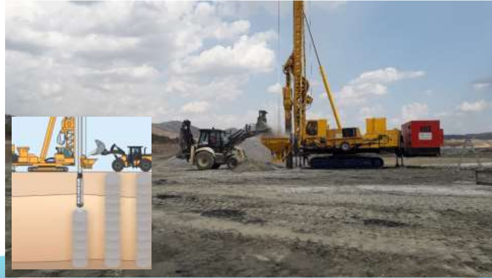
Mejora mediante columnas de grava
