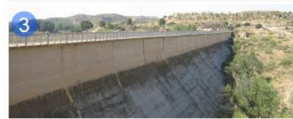
Dique de Los Moros
