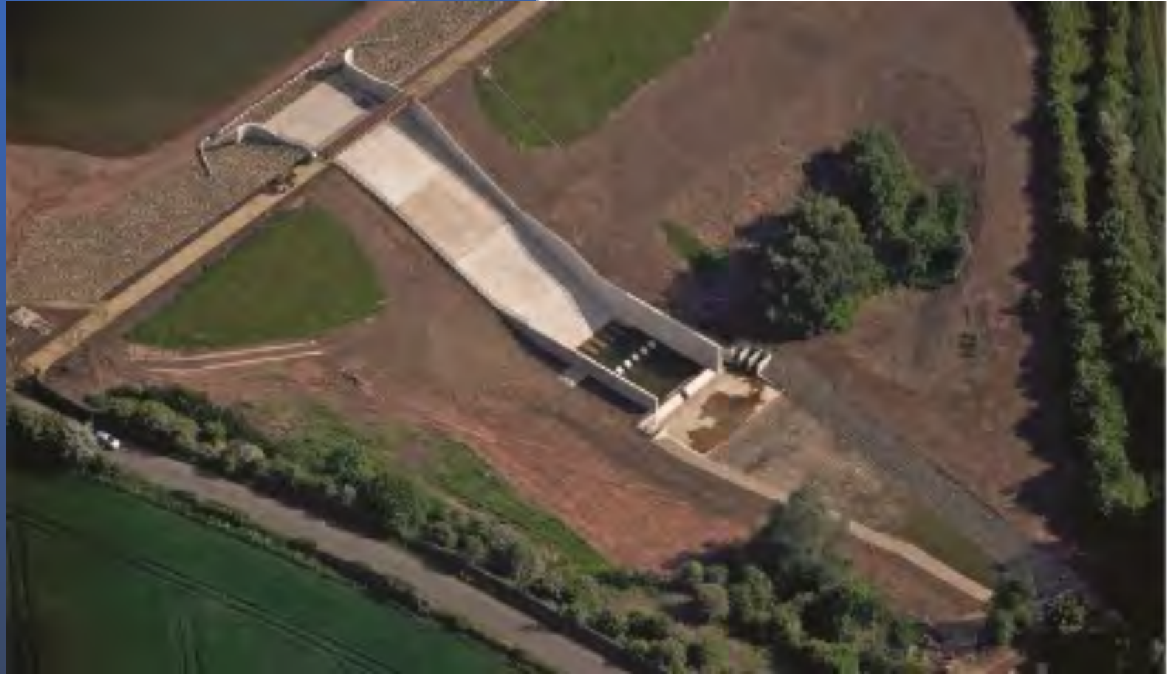
Presa de Ulley, Reino Unido
