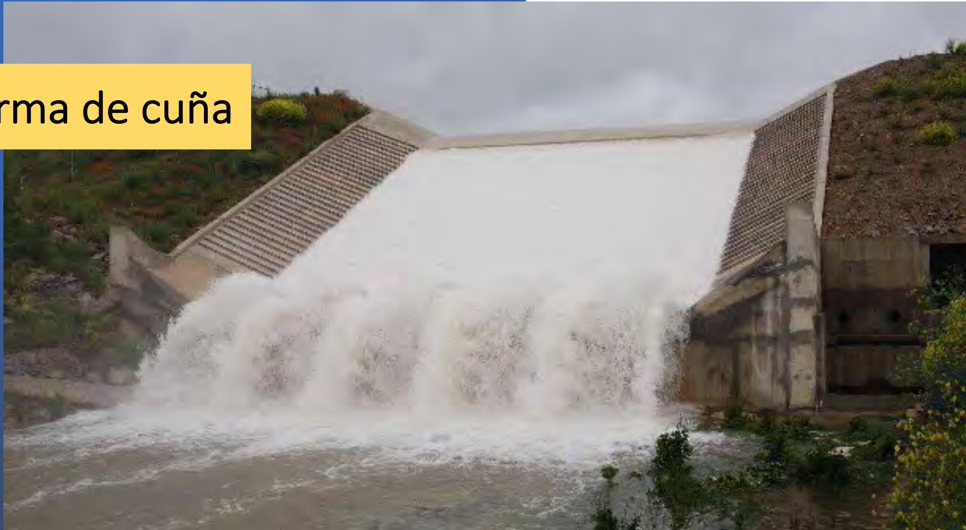
Presa de Barriga, España
