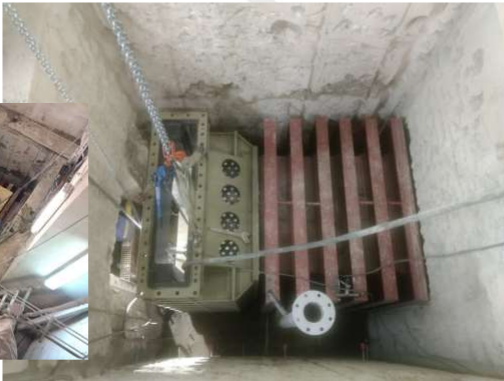
MONTAJE DEL CUERPO DE LA NUEVA COMPUERTA BUREAU
