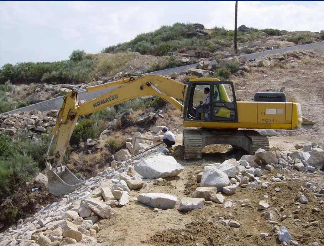
Colocación de la escollera en el paramento
