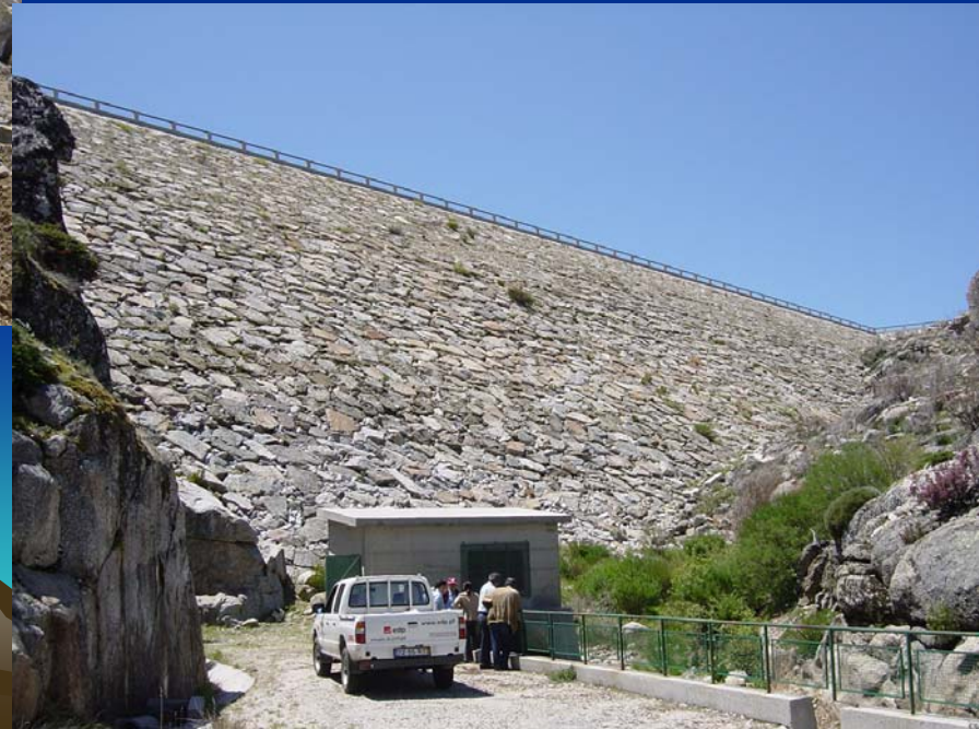
Colocación de la escollera en el paramento
