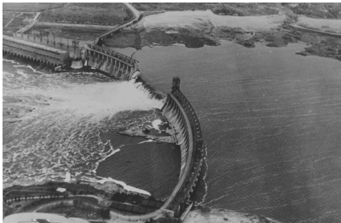
Ilustración 4. Fotografía de la brecha en la presa de Dnieprostroi (Rusia, 1941).
