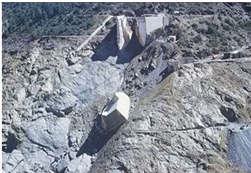
Ilustración 14. Estribo izquierdo de la presa de Malpasset después de la rotura, donde se puede apreciar un “diedro” en el cimientó con la mitad del macizo de gravedad caído. ICOLD TCDS, 2018
