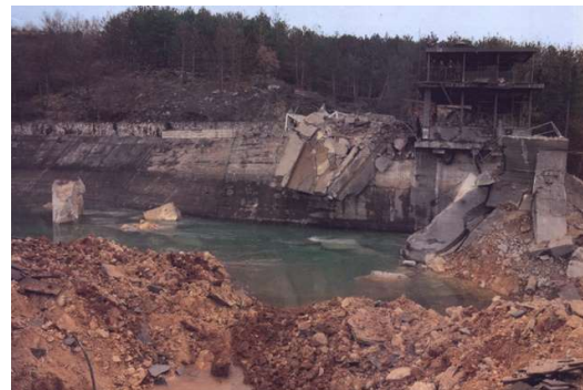
Ilustración 12. Fotografía de los efectos de los explosivos en coronación de presa y aliviadero de Peruća (Croacia).
