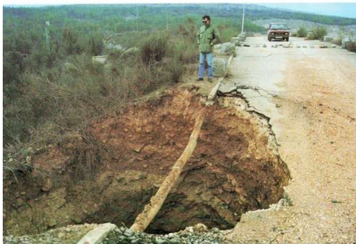
Ilustración 12. Fotografía de los efectos de los explosivos en coronación de presa y aliviadero de Peruća (Croacia).
