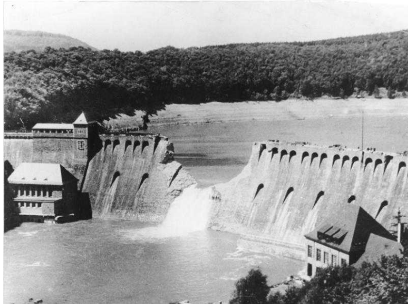
Ilustración 7. Presa de Eder (Alemania. 1943). El 15 de mayo de 1943 se produjo el ataque inglés, pero a pesar de la falta de defensas antiaéreas, no fue nada fácil por su complicada topografía con un fuerte encajamiento de la presa, necesitando tres intentos para su rotura
