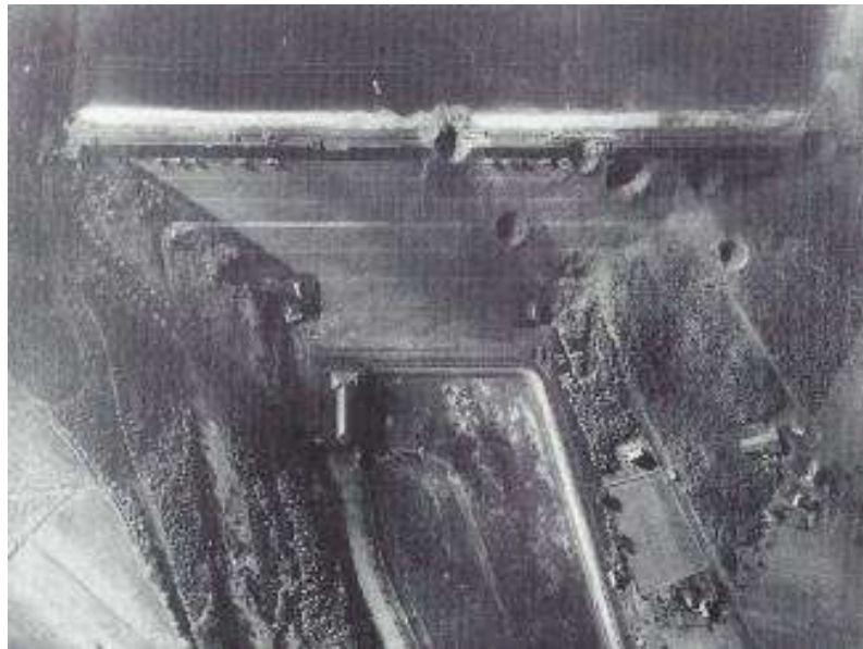
Ilustración 8. . Presa de Sörpe (Alemania. 1943). A pesar de los hundimientos con forma de cráter que se observan en la presa de materiales sueltos, ésta no se brechificó debido a las defensas antiaéreas, la complicada topografía y la niebla.
