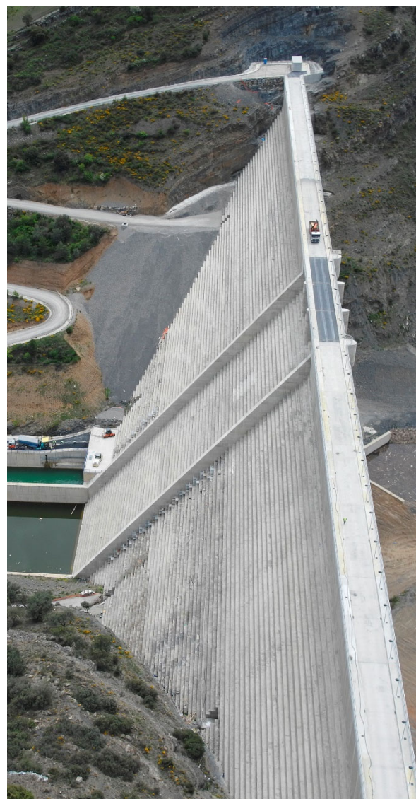
Vista aérea de la Presa de Enciso.
