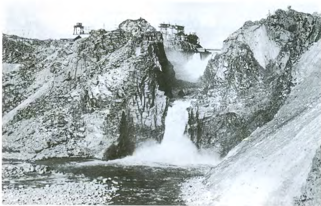
Fotografía 8. VERTIDOS POR ALIVIADERO, 24/01/1935
