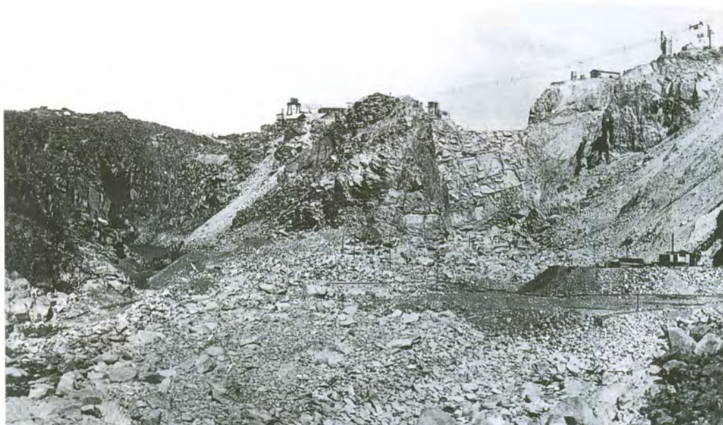
Fotografía 13. ESTADO DEL ALIVIADERO, 22/10/1936
