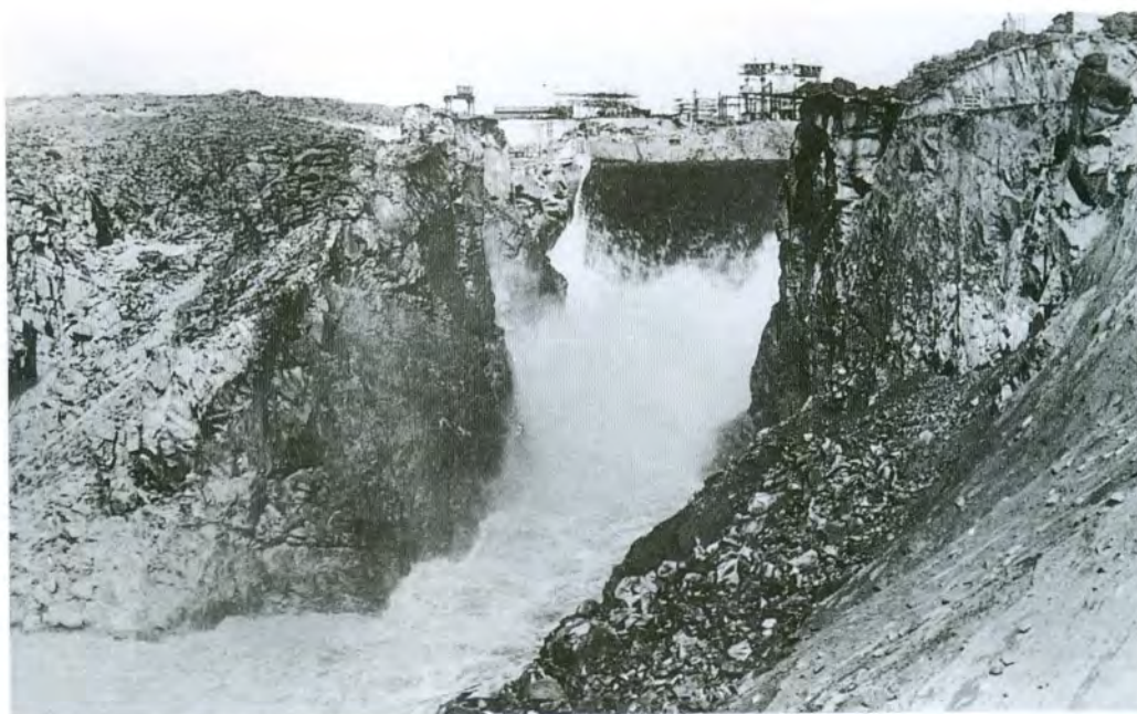
Fotografía 9. VERTIDOS POR ALIVIADERO, 05/03/1935
