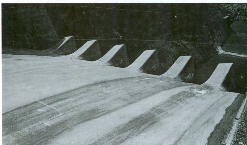
Fotografía 17. DIENTES DEFLECTORES EN EL LABIO DE VERTIDO
