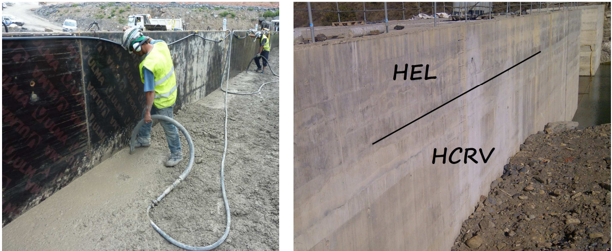
Fig. 2.25B – Losa de ensayo previa de la presa de Enciso (CH Ebro) de 100 m de altura. Ejecución y acabado del paramento empleando HCR vibrado por inmersión sin añadir lechada (HCRV). Comparativamente se ensayó el HEL, es decir añadiendo lechada
