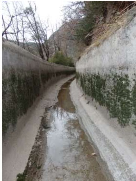
Canal 11 meses después de la limpieza
