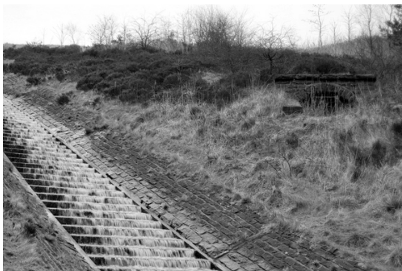
Foto 2. Aliviadero de la presa de Brushes Clough . (Autor: Ch. Wild. Marzo 2007)
