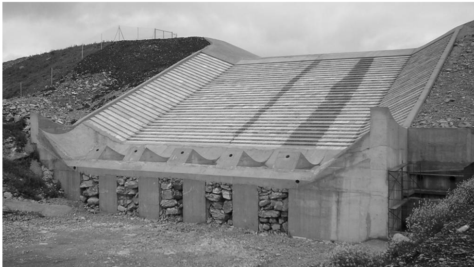
Foto 3. Vista del aliviadero desde aguas abajo
