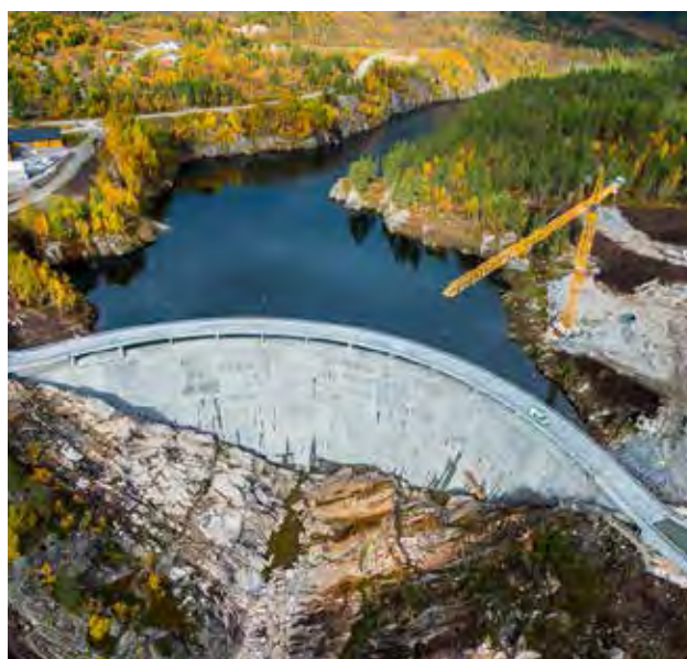
Dam Sarvsfossen, Bykle
