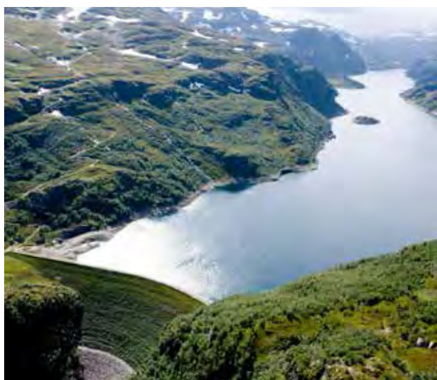
Viddalsdammen Photo: Aerosport / E-CO Energi.
